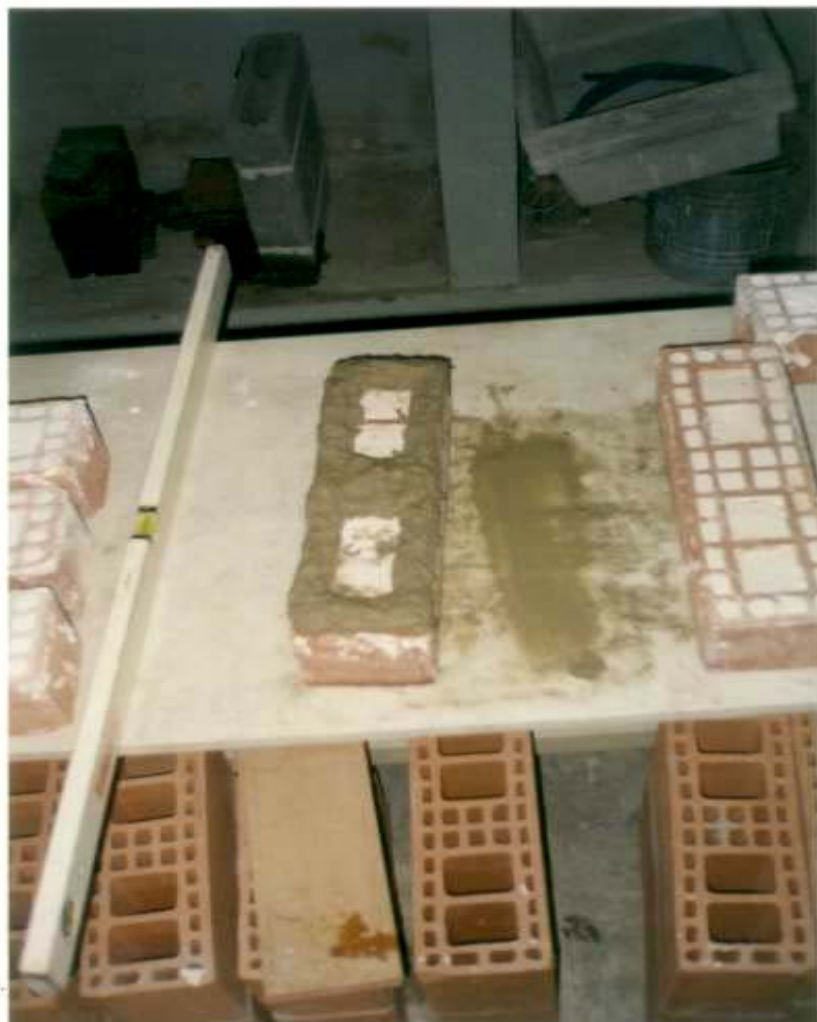
FIGURA 40 - Aplicação da argamassa de assentamento
