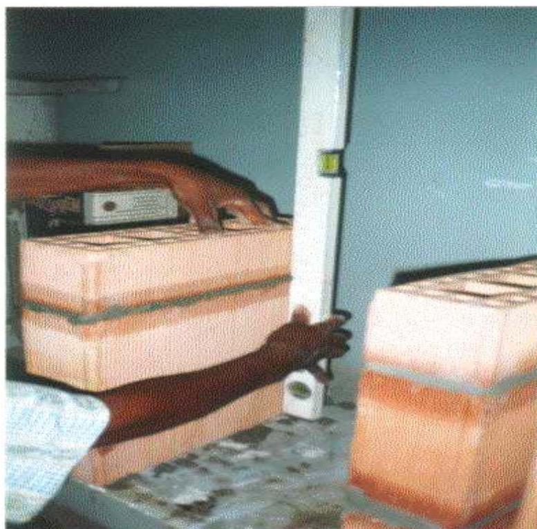
FIGURA 37 - Verificação do prumo e alinhamento do prisma
