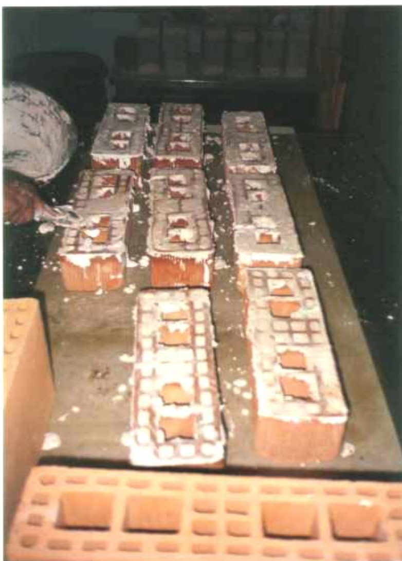
FIGURA 38 - Aplicação de gesso nos furos do bloco cerâmico
