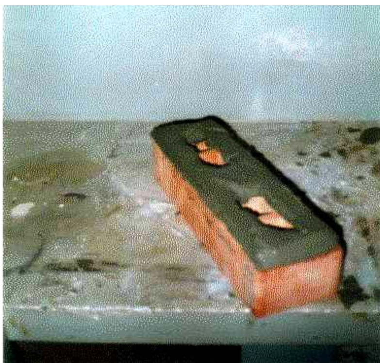
FIGURA 36 - Aplicação da junta de argamassa
