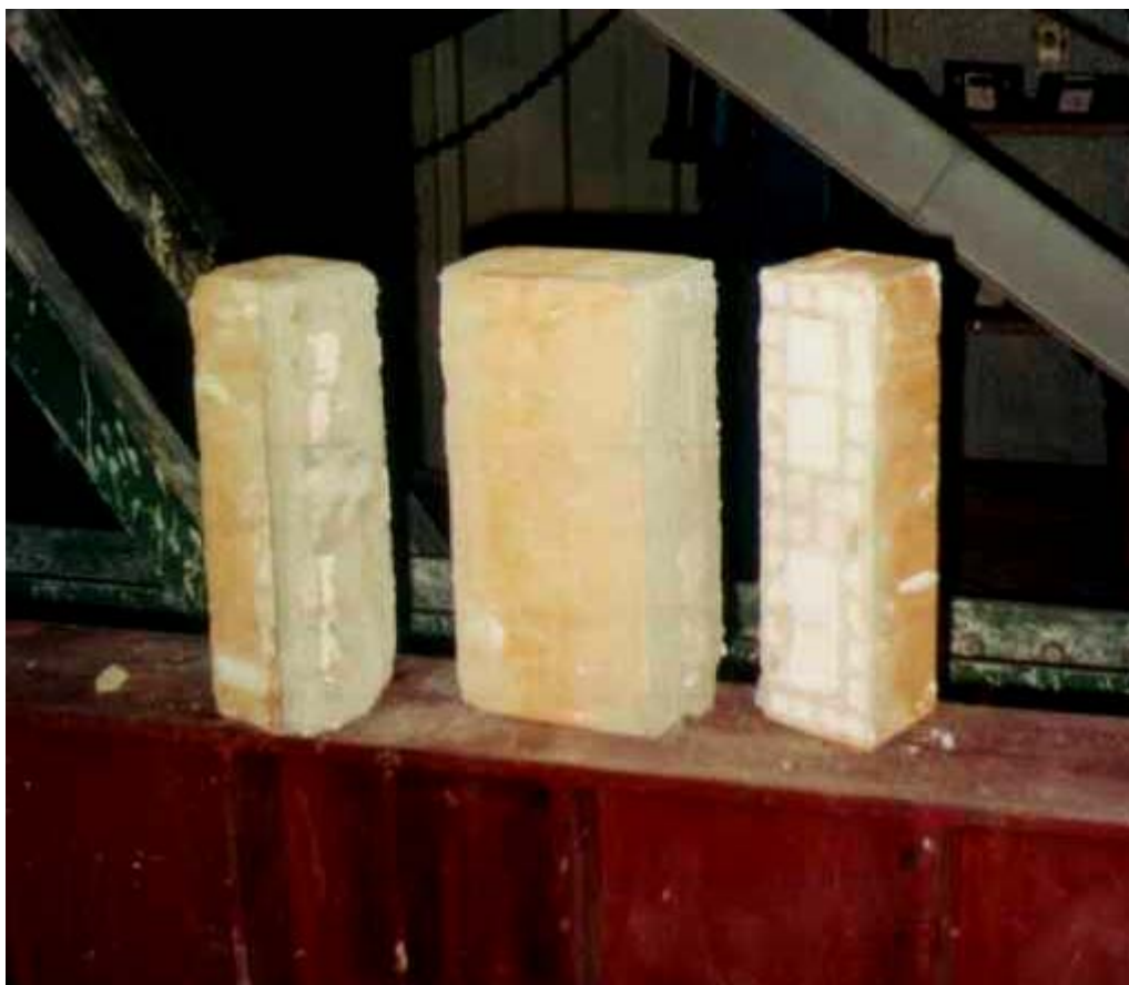
Figura 86 – Descolamento total entre bloco e argamassa em ambas as juntas
