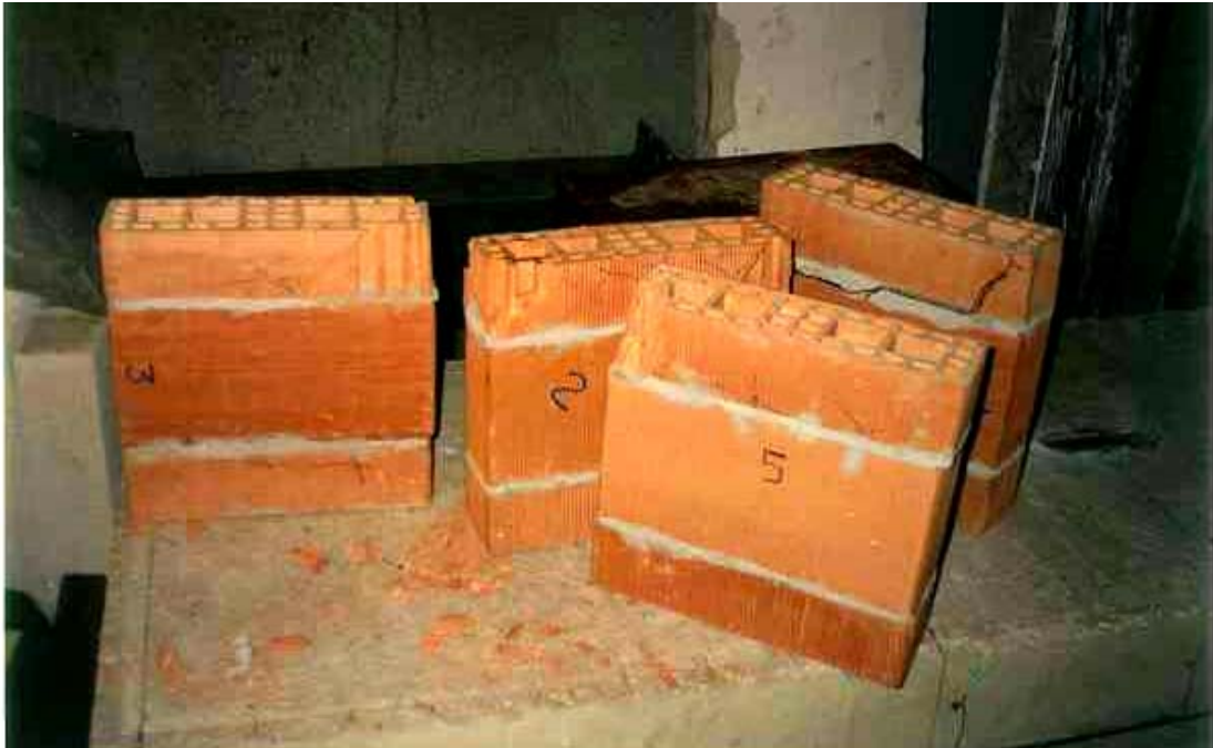
Figura 82 – Esmagamento dos prismas na região do apoio
