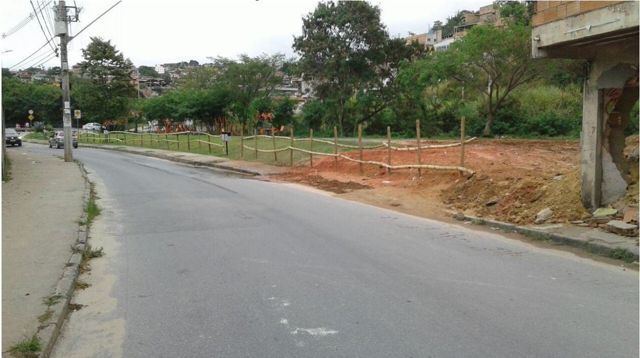
Foto 9 - Mutirão de construção da Cerca de Bambus II – Ribeiro de Abreu
