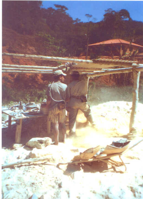
Figura 24 - Condições ambientais de trabalho em unidade de produção artesanal – serra elétrica.
