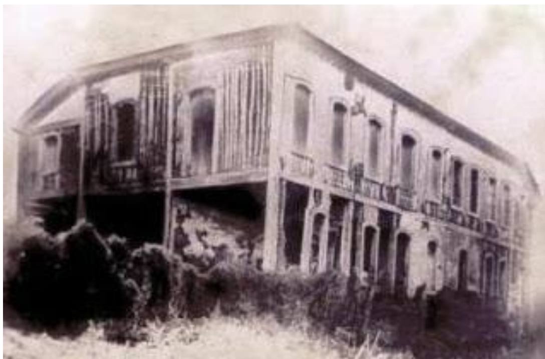
Figura 21- Casarão de Joaquina de Pompéu, demolido em 1954 101
