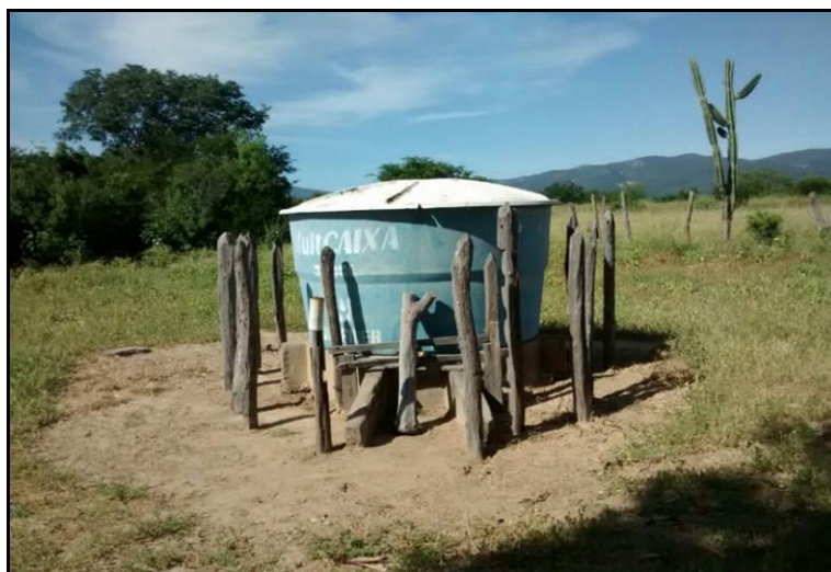
Figura 5.9: Caixa d'água comunitária localizada na comunidade de Barreiro Amarelo para armazenamento da água utilizada para beber
