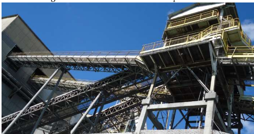
Figura 5 - Circuito de correias transportadoras.
