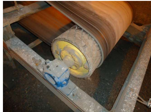
Figura 24 - Tambor e mancal após manutenção.
