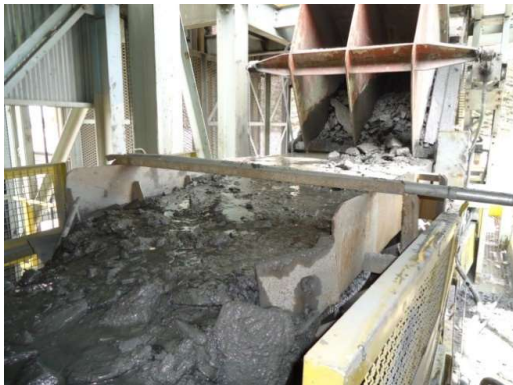
Figura 11 - Entupimento por excesso de umidade.
