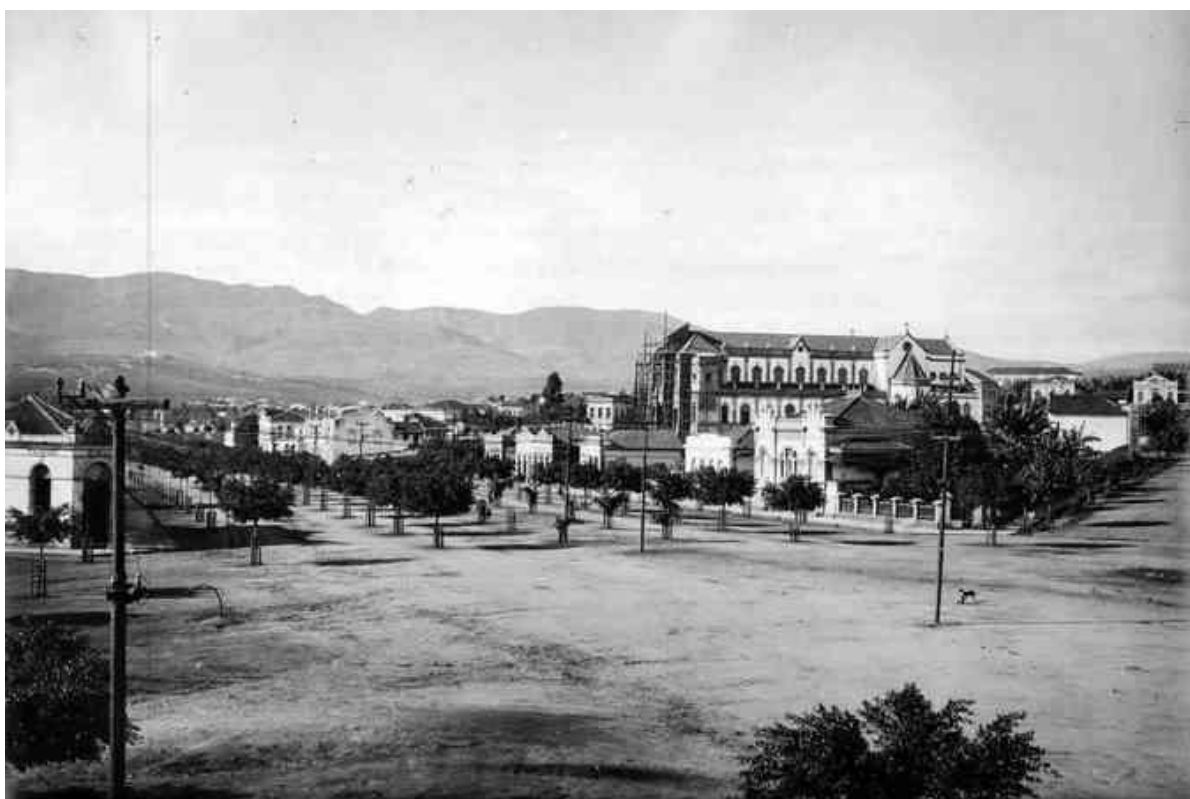
Aspecto da Avenida Afonso Pena, vendo à direita as obras de construção da Igreja São José
