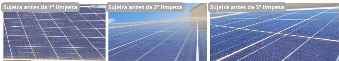
Figura 27 – Característica de Deposição da Sujeira na Usina FV - TESLA.
