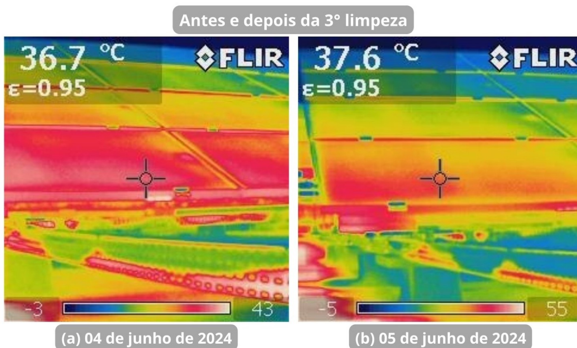
Figura 42 – Antes e Depois da 3° Limpeza - Arranjo F1 e F2.
