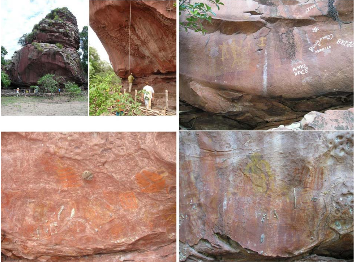
Figura 12 – Vista geral do abrigo, detalhes de pinturas rupestres e alguns problemas de conservação da Pedra da Gameleira, Castelo do Piauí.
