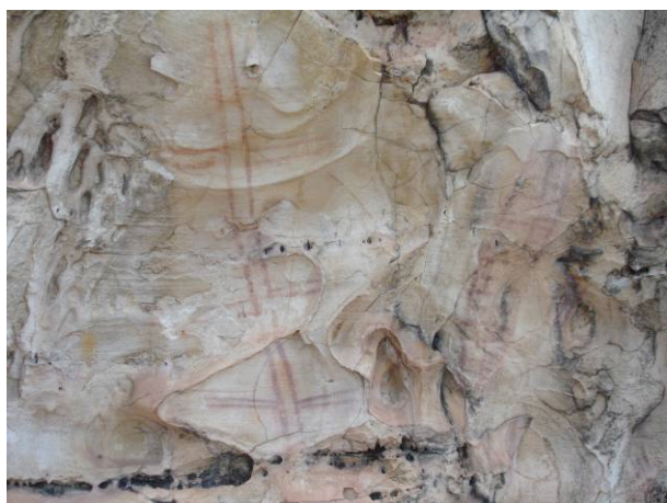
Fig.8 Remoção de galerias de cupins com auxílio de compressas. Pedra do Lagarto. Fonte: NAP-UFPI.
