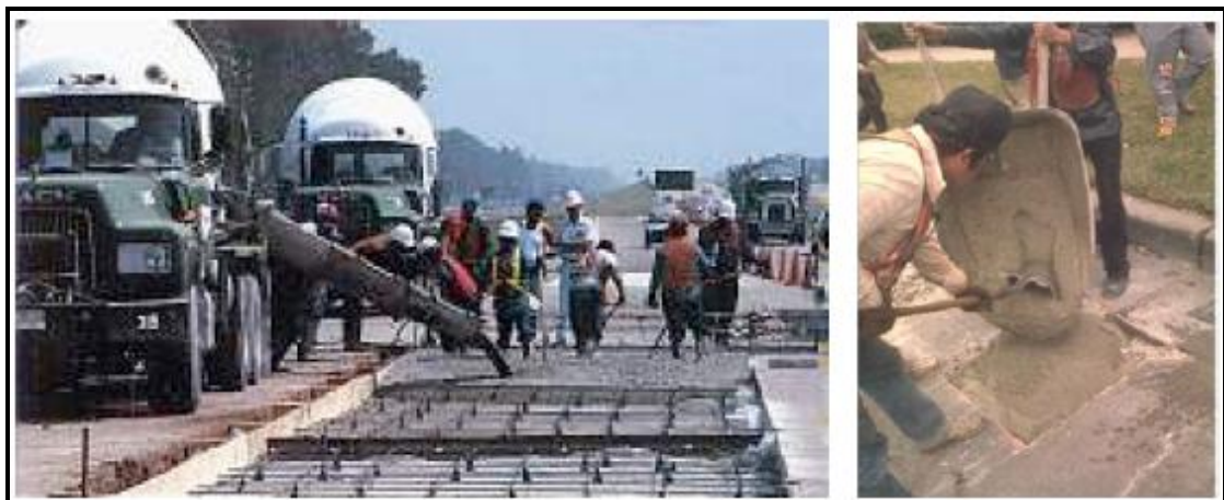
Figura 3.10- Uso do geopolímero Pyrament, nos Estados Unidos, como material de reparação de rodovias
