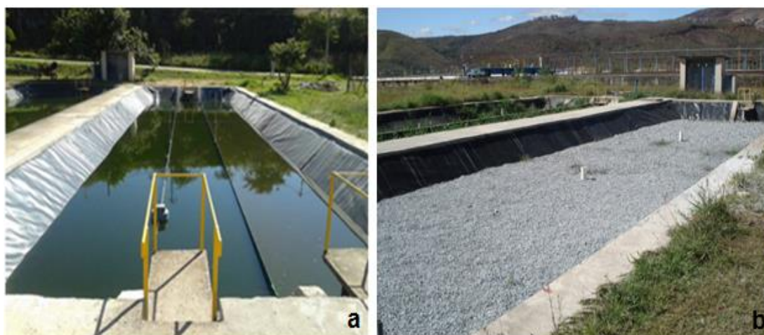
Figura 6.3: Estrutura física atual da Lagoa de polimento 2 (a) e da Lagoa de polimento 3 com filtro grosso (b) após reforma em 2014 no CePTS/UFMG/COPASA.
