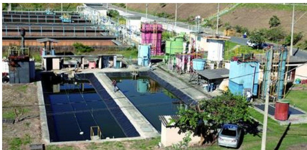
Figura 6.2: Reator UASB e lagoas de polimento (1 e 2) - CePTS/UFGM/COPASA.
