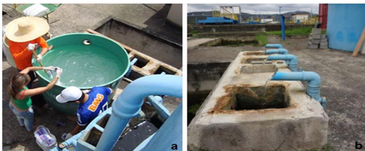
Figura 7.21: Local de preparação e (a) e aplicação (b) da massa de nitrato de sódio antes de ser direcionado para as lagoas.
