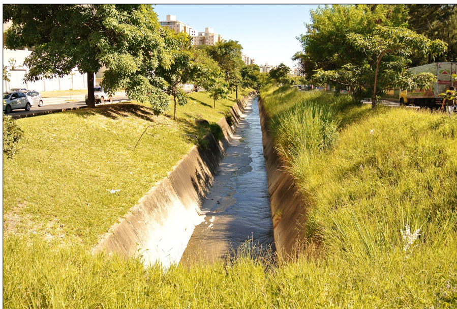
Figura 37 – Trecho de canalização do córrego Flor d'Água, em canal aberto (Foto: Camila Yarla, Março de 2017).
