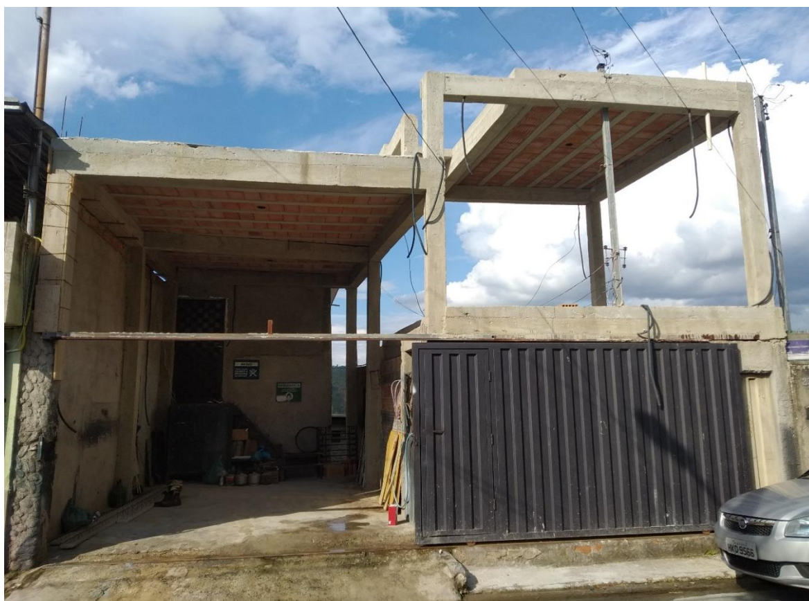
Figura 19 – Casa em construção.
