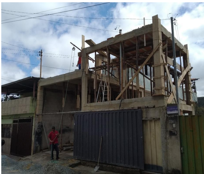
Figura 22 – Registro casa em construção – jul. 2021.
