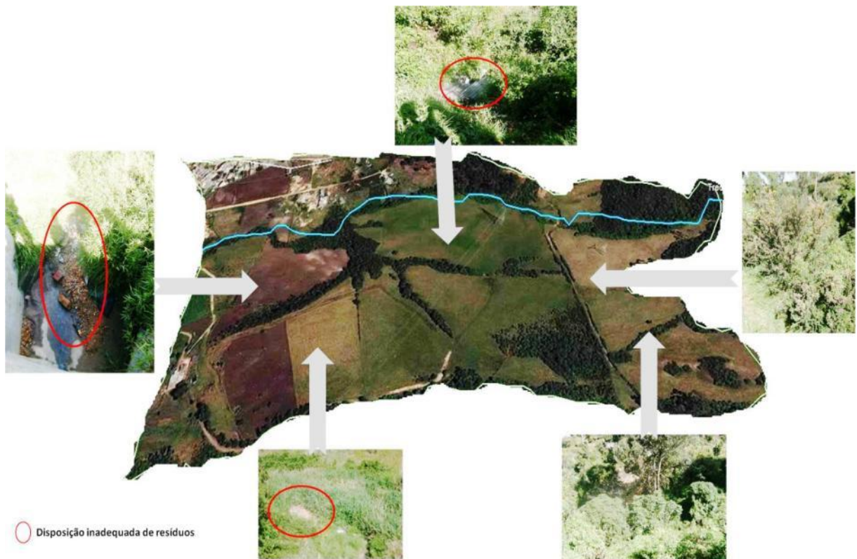
Figura 6.6 - Subtrecho 1, Trecho de torrente Bolonia (Fonte: Montagem em imagem de Google Earth 2013)
