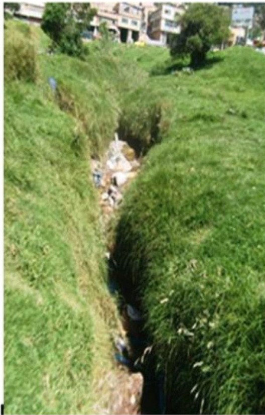
Fotografia 11 – Desembocadura do Trecho de torrente Bolonia
