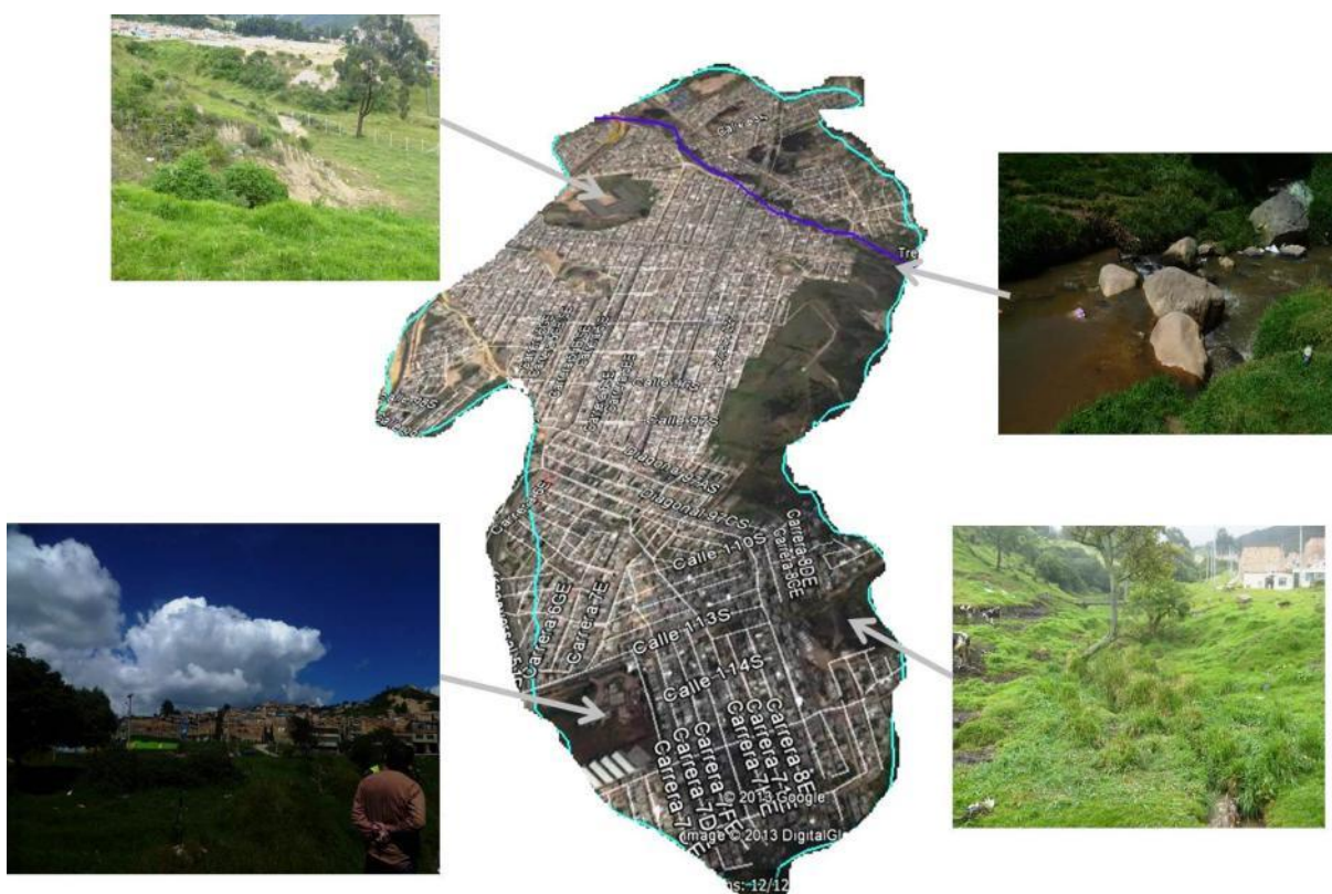
Figura 6.14 - Subtrecho 2, Trecho de torrente Yomasa (Fonte: Montagem em imagem de Google Earth 2013)
