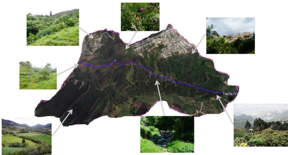
Figura 6.13 - Subtrecho 1, Trecho de torrente Yomasa (Fonte: Montagem em imagem de Google Earth 2013)
