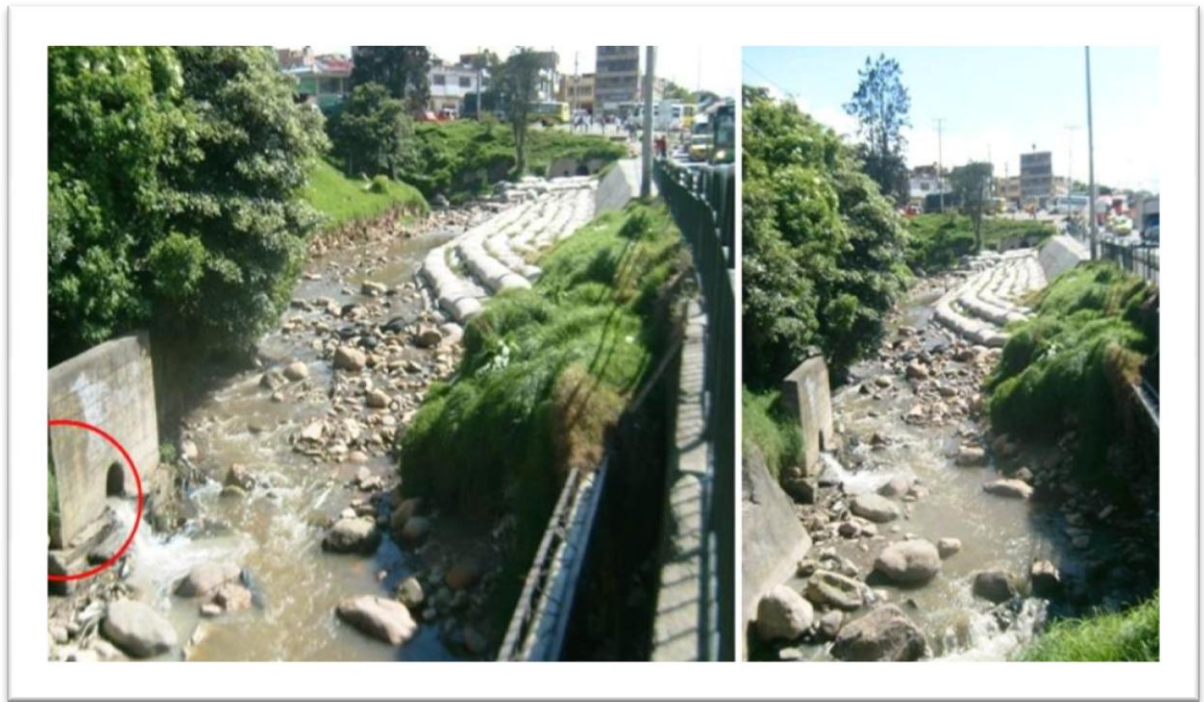
Fotografia 19- Vertimento de águas servidas e residuais ao trecho. Igualmente observa-se obras de contenção e mitigação de inundações
