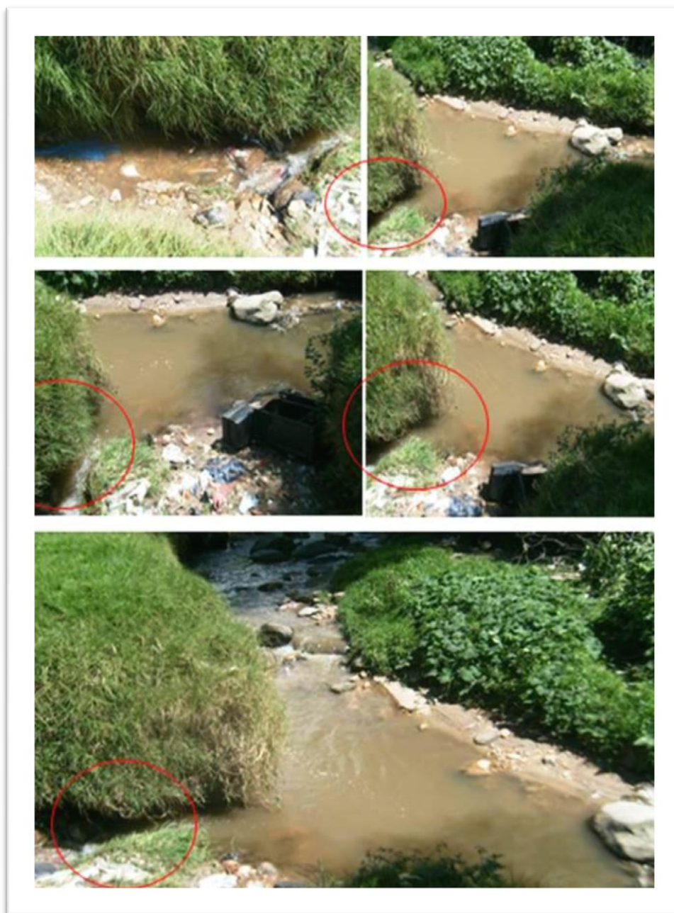
Fotografia 10 – Desembocadura do Trecho de torrente Bolonia no Trecho de torrente Yomasa
