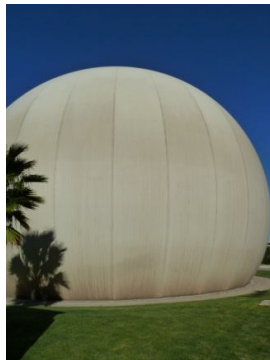
Figura 5-19: Vista geral do gasômetro para armazenamento de biogás na ETE Pinedo 2, Valência.
