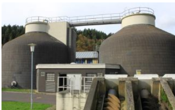
Figura 1-23: Vista dos biodigestores da ETE Taunusstein, Alemanha.
