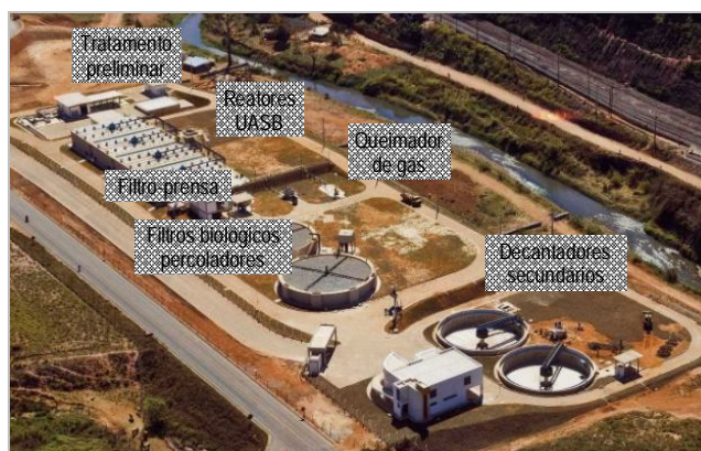
Figura 4-2: Vista geral das unidades da ETE Laboreaux .
