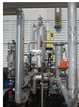
Figura 1-29: Sistema de purificação do biogás na ETE Arrudas.
