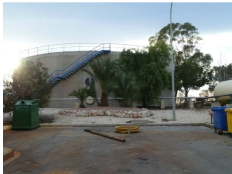
Figura 5-11: Vista geral do biodigestor de lodo da ETE Rincón de León, Alicante. Fonte: Autor
