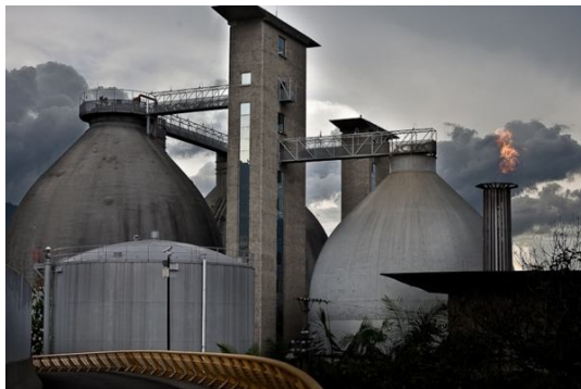
Figura 1-19: Vista dos biodigestores da ETE San Fernando, Colômbia. Fonte: EPM (2007)
