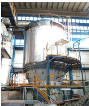
Figura 5-16: Vista geral do incinerador que processava lodo da ETE de Pinedo 1, Valência. Fonte: Autor
