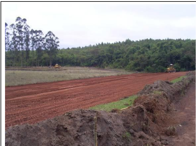
Obras do retaludamento da Barragem B1 (2008).
