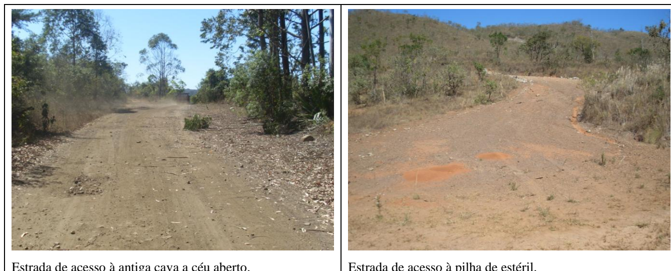
Figura 36. Estradas de acesso e circulação da Mina da Cachoeira (2010).
