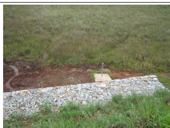
Implantação de sistema de drenagem no pé da Barragem B1 e instalação de piezômetro (2007).
