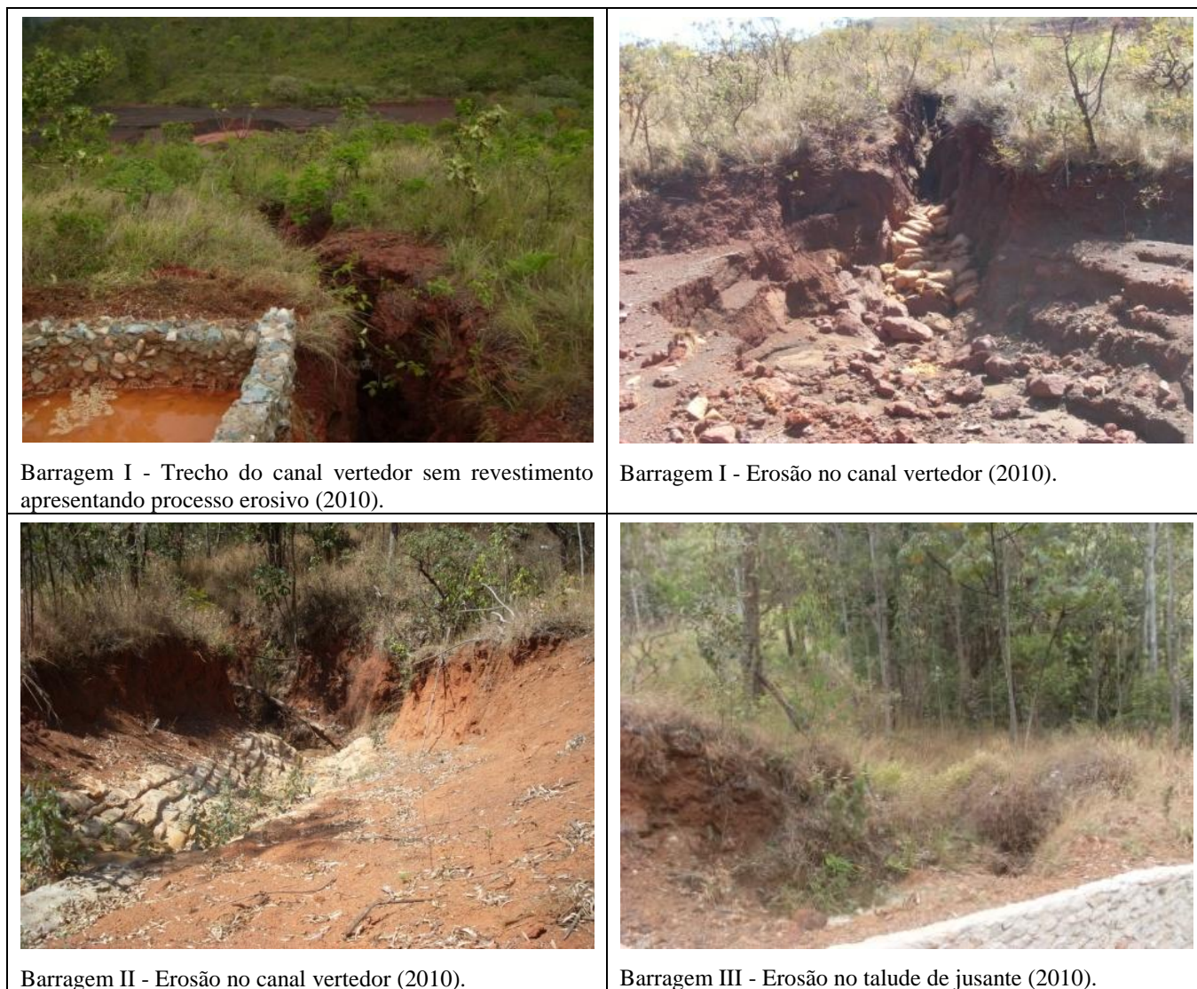
Figura 51. Inconformidades das barragens da Mina de Casa Branca.
