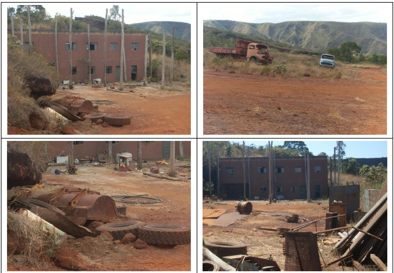
Figura 50. Edificações, equipamentos e veículos abandonados (2010).
