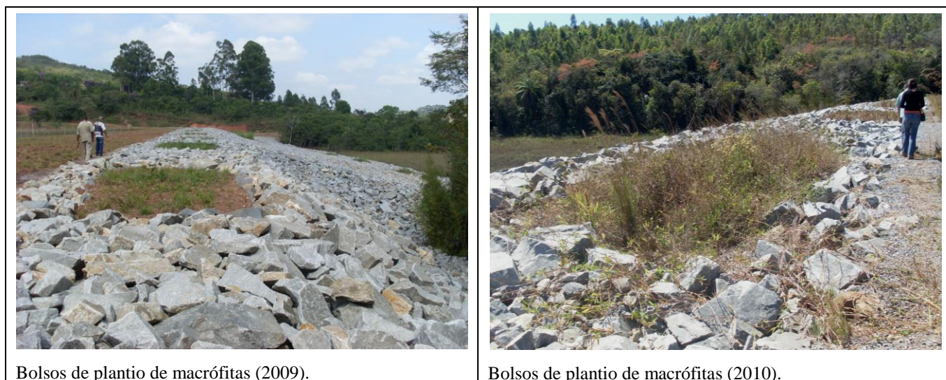
Figura 27. Plantio de macrófitas no talude em enrocamento.
