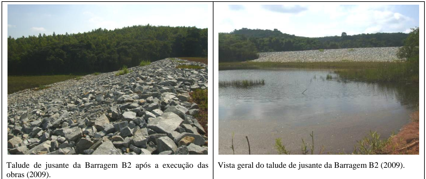
Figura 25. Execução das obras de descomissionamento da Barragem B2.
