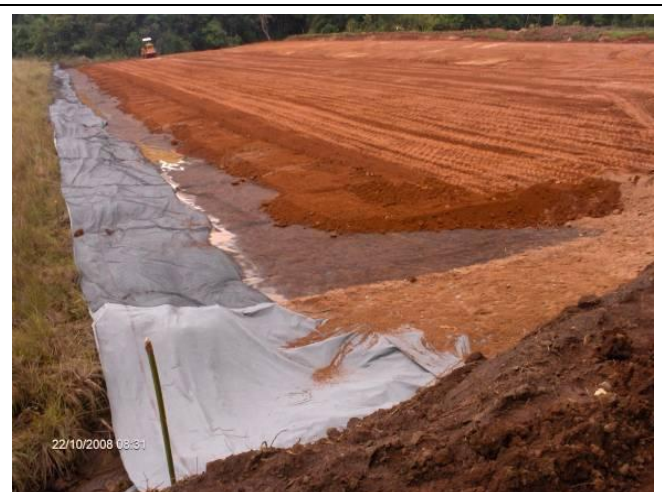
Execução do dreno com colocação de bidim e geogrelha na Barragem B1 (2008).
