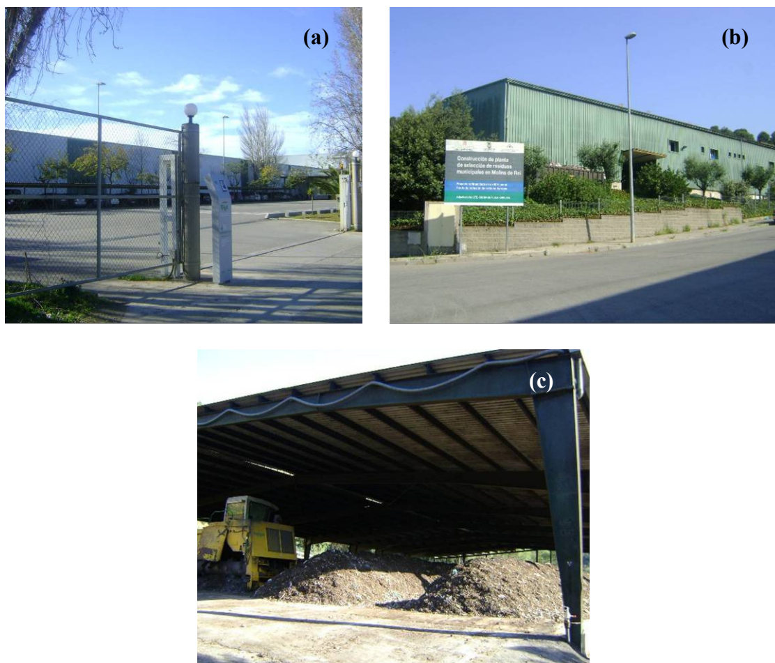
Figura 5.14 – Unidades exclusivamente de triagem e seleção da Região Metropolitana de Barcelona – (a) Unidade de Gavà-Viladecans, (b) Unidade de Mollins de Rei e (c) Unidade de Torrelles de Llobregat.
