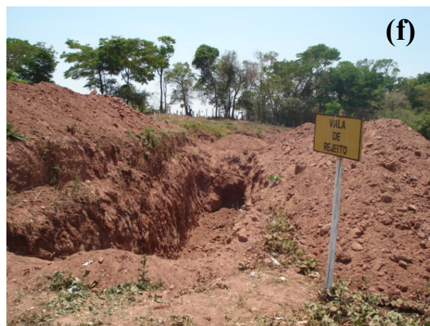
Figura 4.1 – Principais unidades de uma UTC - Recepção (a), Mesa ou esteira de triagem (b), Pátio de compostagem (c), Baías para depósito de materiais recicláveis (d), Instalação de apoio (e), Vala de rejeitos(f). Fonte: FEAM (2006b); FEAM (2007a); Catapreta (2007).
