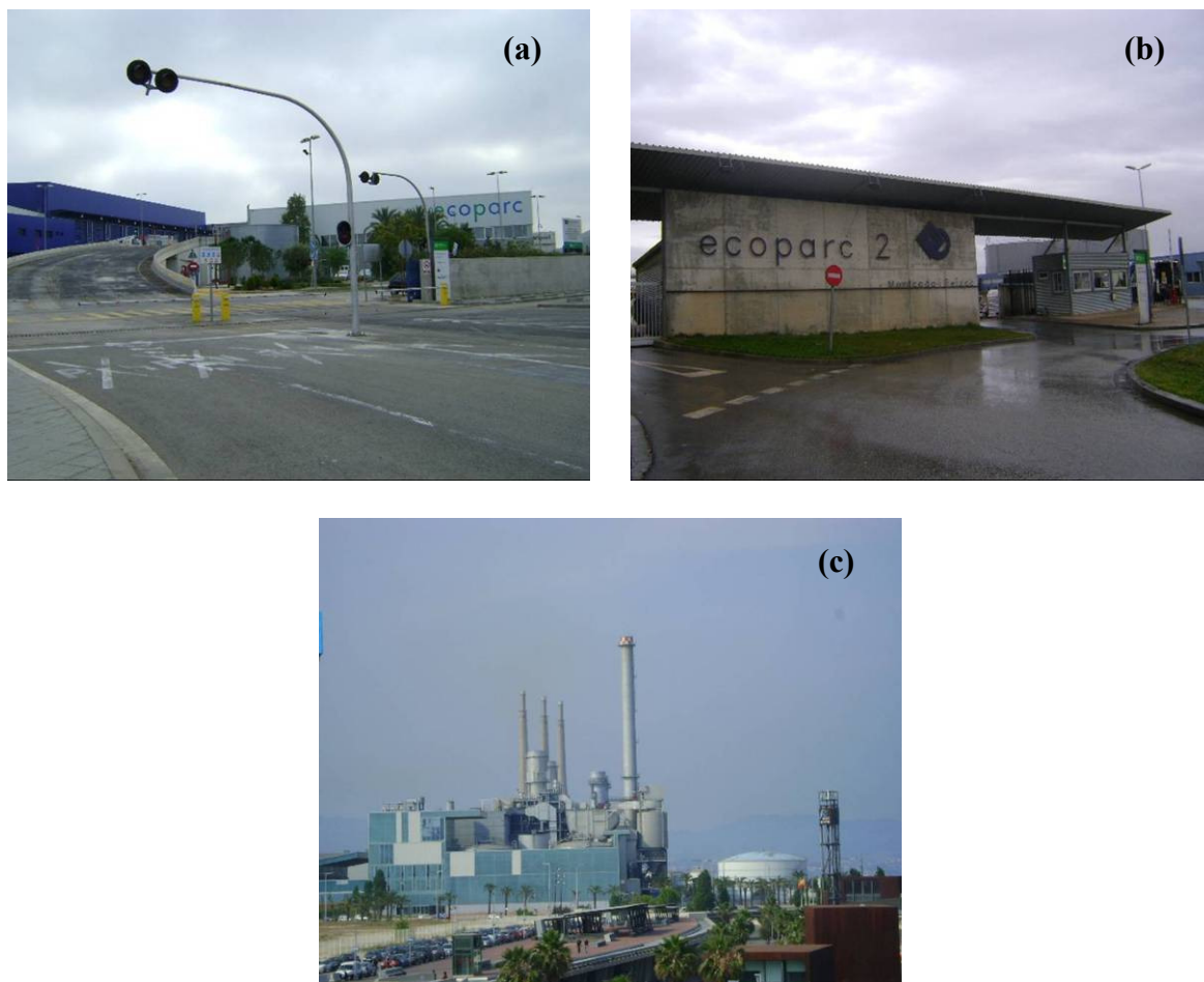
Figura 5.13 – Ecoparques da Região Metropolitana de Barcelona – (a) Ecoparque de Barcelona, (b) Ecoparque de Montcada y Reixac e (c) Ecoparque do Mediterrâneo.
