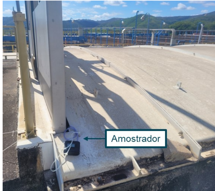
Figura 4.4 – Amostrador de pequeno volume no canal por onde passa o afluente dos decantadores primários
