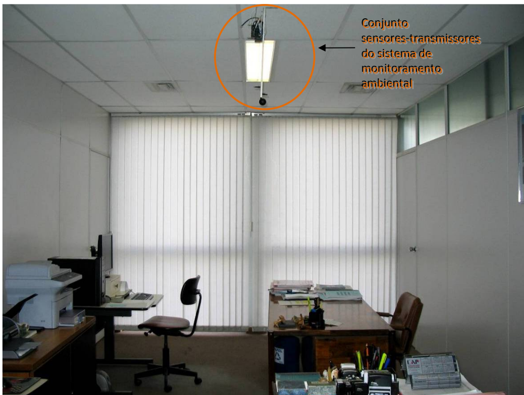
Figura 16 - Foto do sistema de monitoramento integrado ao ambiente analisado
