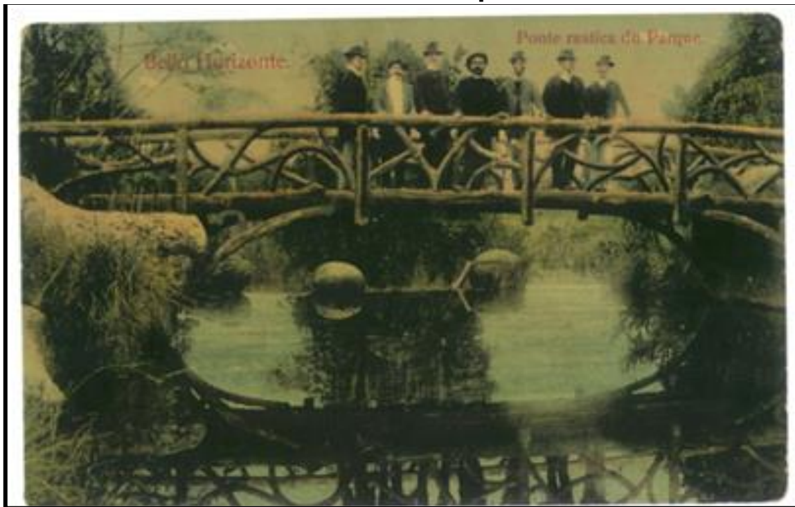
Figura 46 - Destaque para o grande vão sob a ponte rústica até o nível d'água, indicativo contundente da realização de obras de aterro e alterações de cotas altimétricas do terreno do sítio original onde se assentou o Parque.
