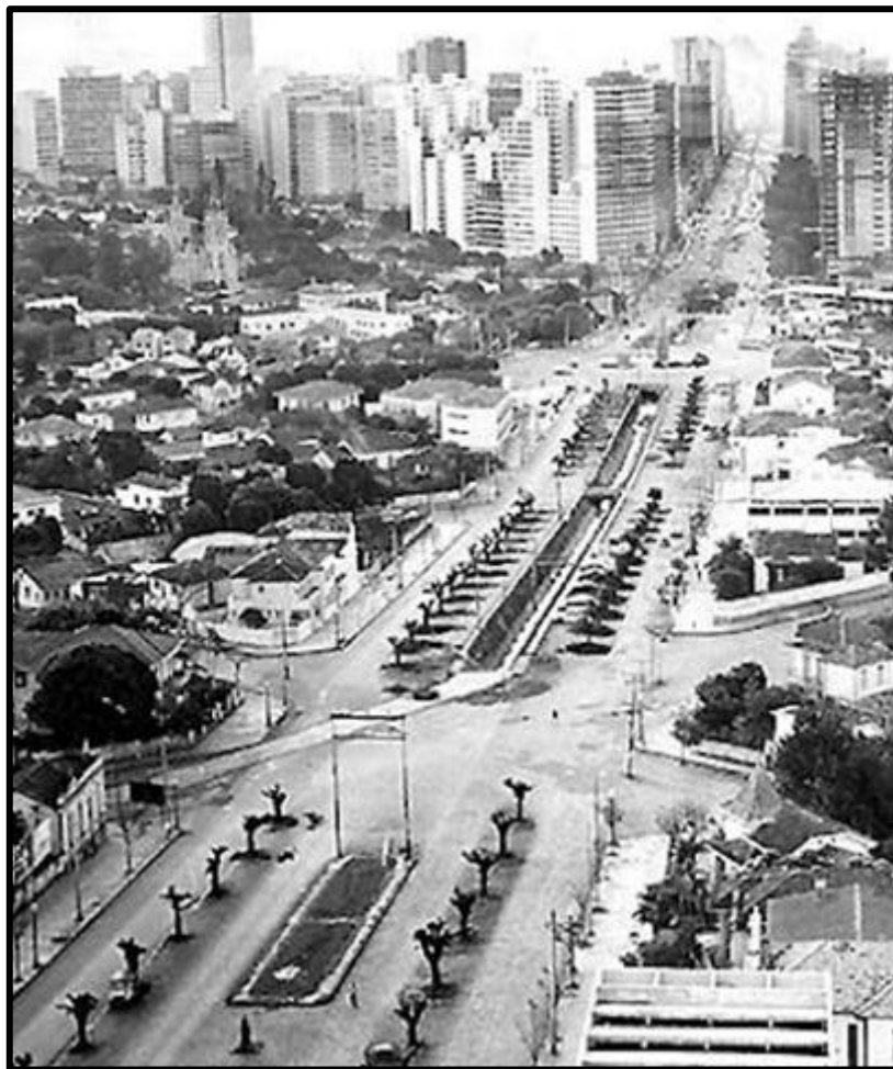
Figura 34 - Trecho da av. Afonso Pena, com o córrego Acaba Mundo ao centro. (1960.)
