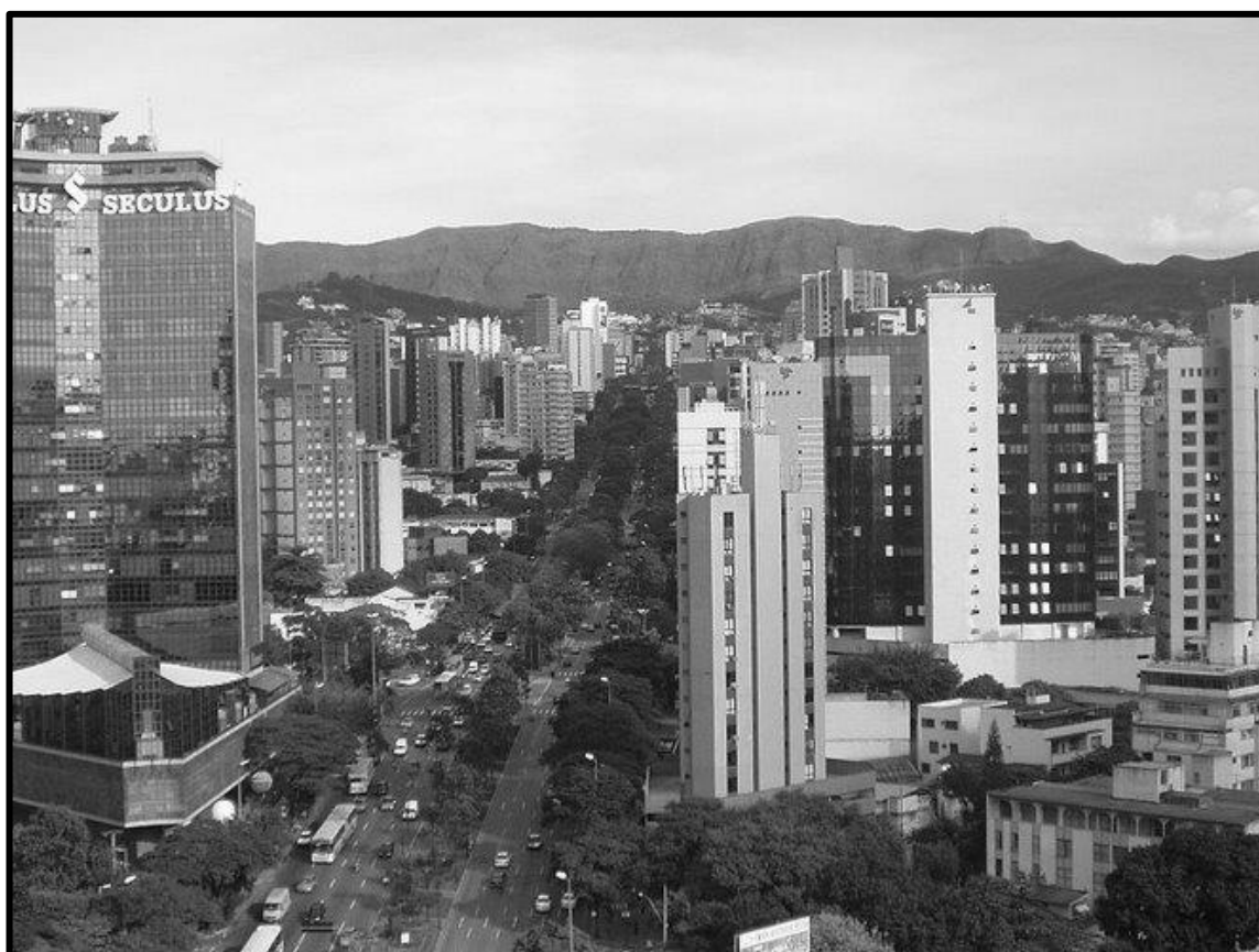
Figura 41 - Av. Afonso Pena atualmente, com o córrego Acaba Mundo capeado abaixo do canteiro central (em destaque).
