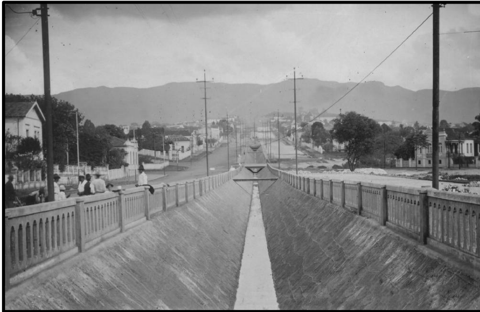
Figura 29 - Córrego Acaba Mundo retificado na Avenida Afonso Pena (década de 1920)
