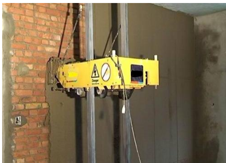
Figura 5: Utilização de máquinas no auxílio da construção civil. (Fonte: disponível em: http://www.solostocks.com.br/img/maquina-de-rebocar-paredes-automatica-1054047z1.jpg )
