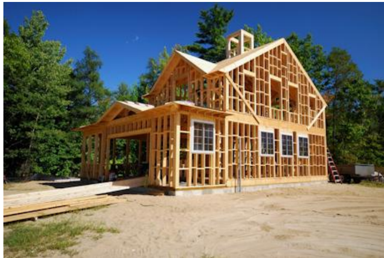
Figura 7: Casa construída no sistema de wood framing .
