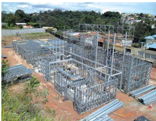
Figura 10: Utilização do steel framing em escolas de Belo Horizonte/MG Redução de até 16 meses no prazo de construção original das construções com a substituição da alvenaria convencional pelo steel framing. (Fonte: Revista Infraestrutura Urbana. Edição 36 - Março/2014)
