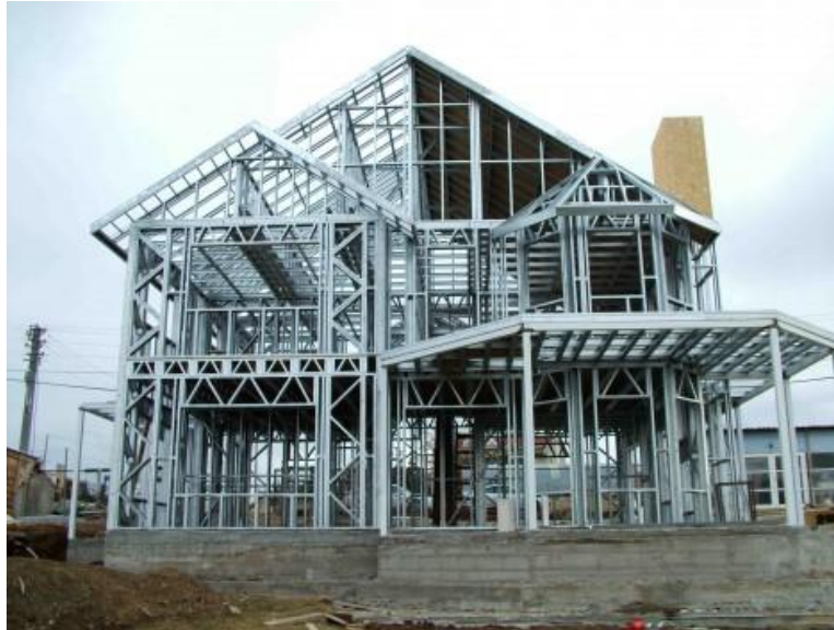
Figura 8: Casa construída no sistema de steel framing .
