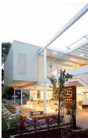
Figura 11: Projeto da Casa Natura, em São Paulo. Utilização de sistema híbrido com estrutura metálica no primeiro pavimento, e o light steel framing no pavimento superior. (Fonte: Revista Arquitetura e Urbanismo. Edição 229. Abril, 2013)
