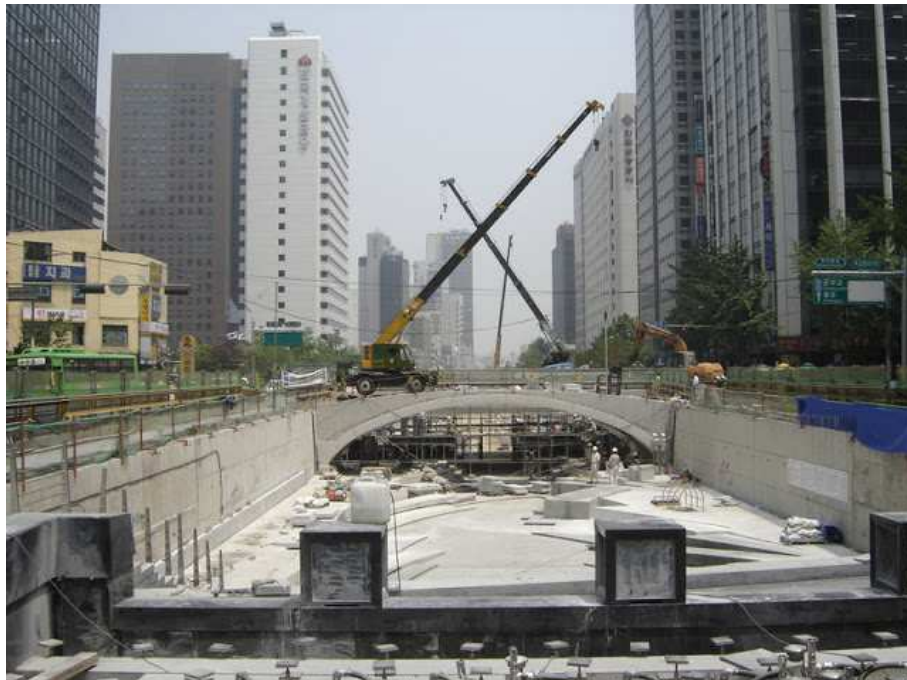
Figura 30 – Obras para retirada da via expressa sobre o rio Cheonggyecheon
