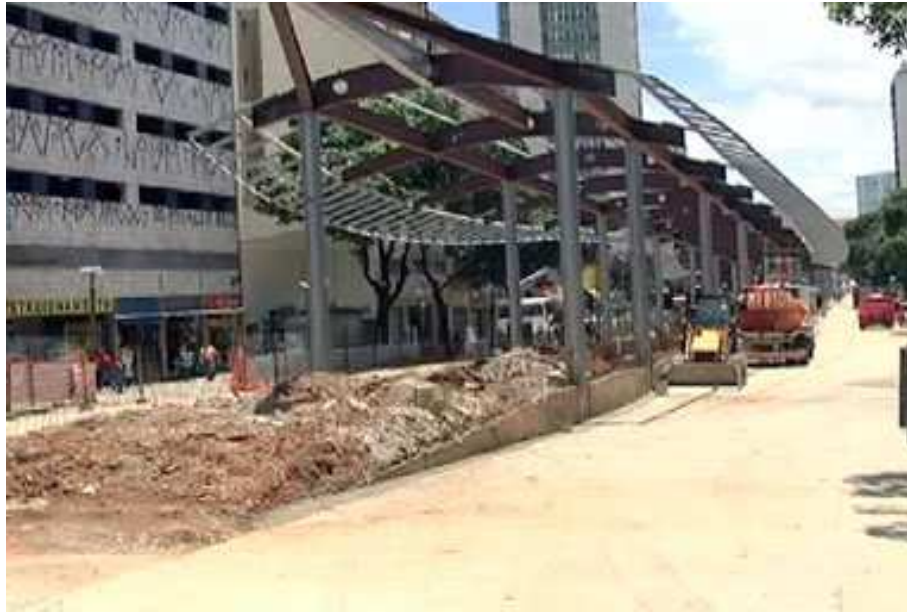
Figura 52 – Obras construção estação de embarque/desembarque BRT – Avenida Santos Dumont Fonte: CRUZ, 2012.
