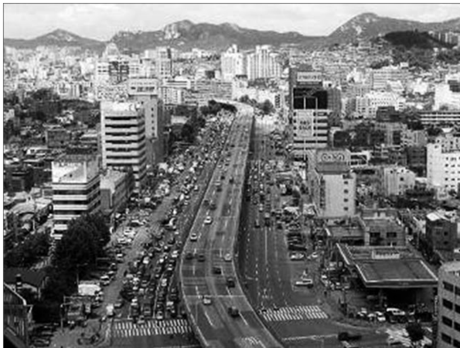
Figura 29 – Via expressa sobre o rio Cheonggyecheon – Seul/Coreia do Sul
