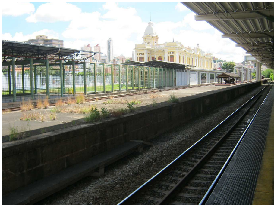
Figura 40 – Vista Estação Central ao fundo, trilhos trem e metrô Fonte: Acervo Particular da autora.
