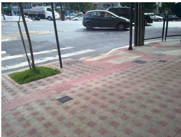
Figura 12 – Sinalização calçada com piso tátil (Avenida Uruguai – Belo Horizonte/MG)
