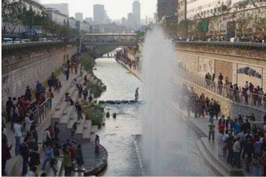
Figura 31 – Obras de revitalização do rio Cheonggyecheon concluídas Fonte: PRIETO, 2011.
