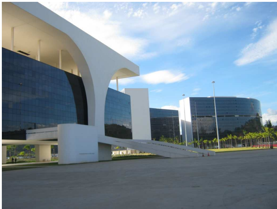
Figura 24 – Palácio Tiradentes e edifícios das secretarias ao fundo – Cidade Administrativa Presidente Tancredo Neves
