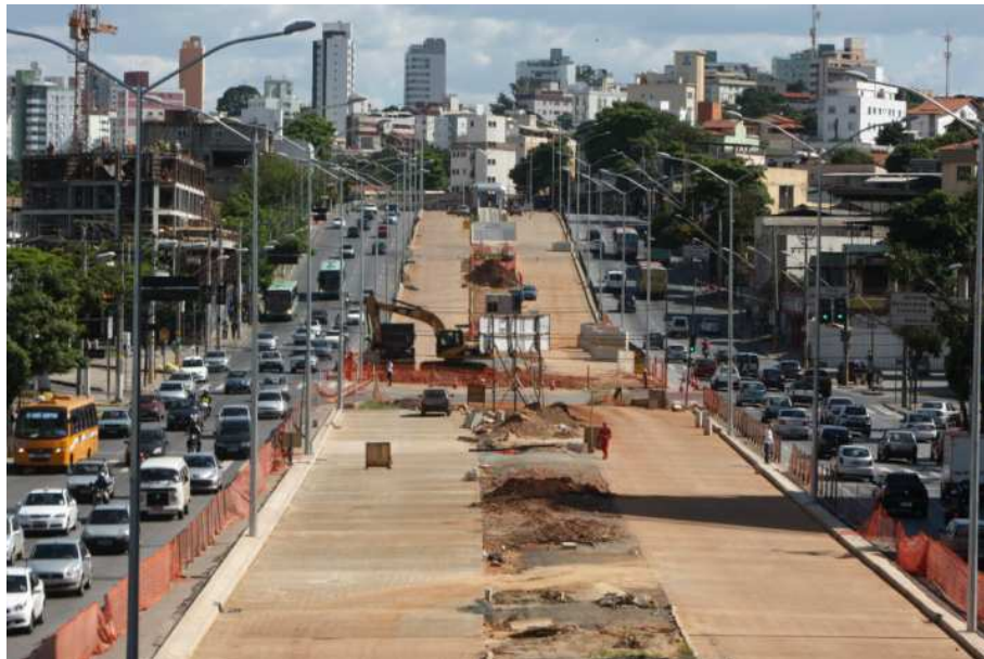
Figura 51 – Obras corredor viário BRT – Avenida Cristiano Machado
