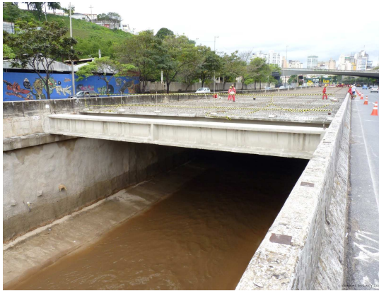
Figura 22 – Avenida dos Andradas com obras em andamento para cobrimento do Ribeirão Arrudas Fonte: BORSAGLI, 2011.
