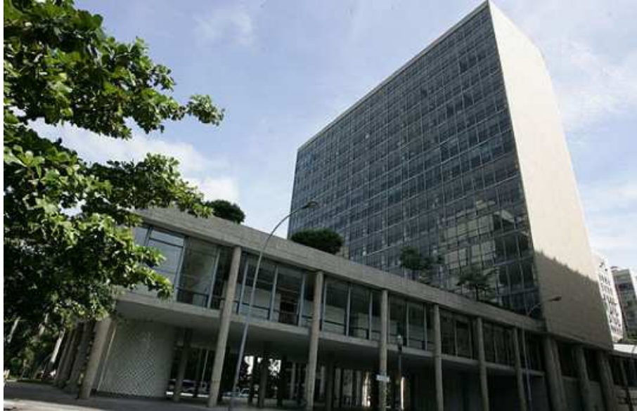
Figura 07 – Prédio do Ministério da Educação e Cultura - Rio de Janeiro/RJ Fonte: SINAENCO, 2011.
