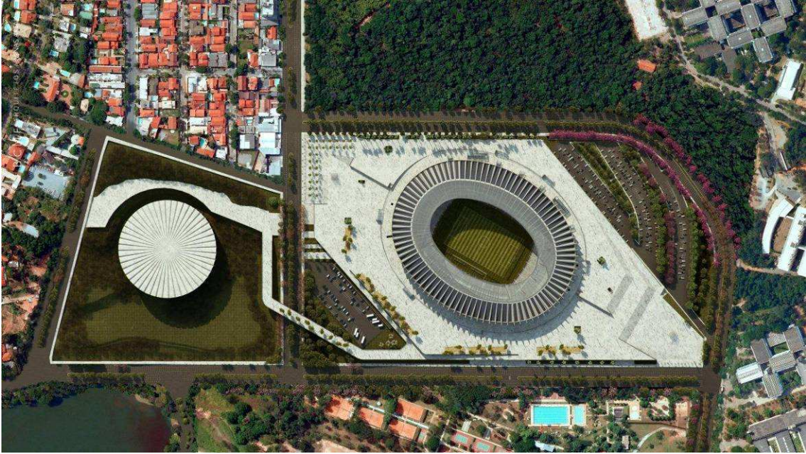
Figura 2 - Complexo do Mineirão. Crédito: BCMF Arquitetos
