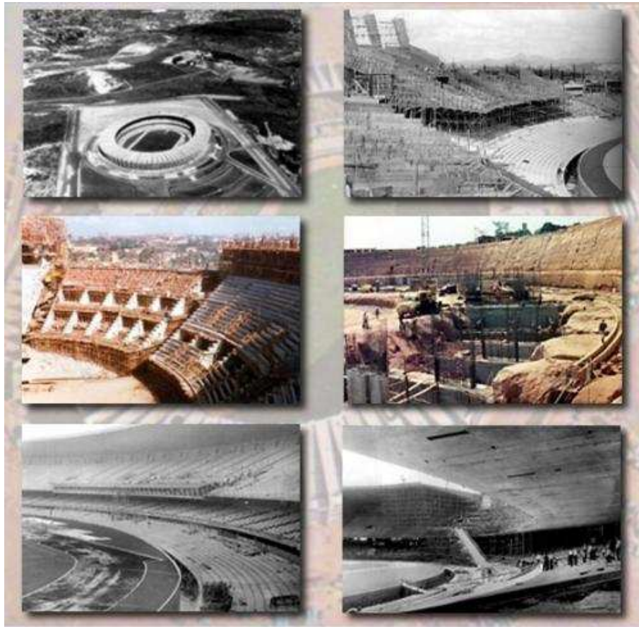
Figura 1 – Construção do Mineirão Fonte: Edital de concessão administrativa do Estádio Mineirão.
