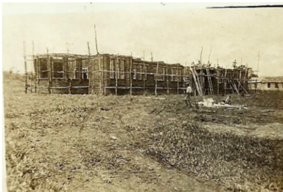
Figura 8 - Hospital Dr. Pacífico Mascarenhas durante sua construção
