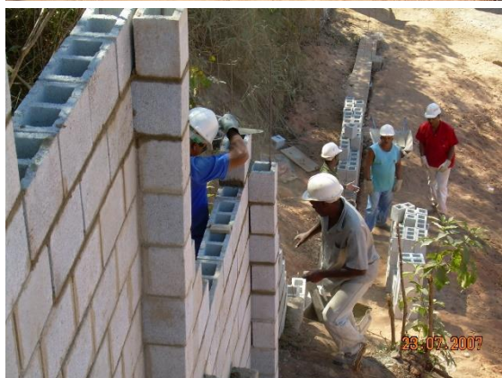
Figura 17: Homens edificando o muro de divisa, considerada a “escola de alvenaria” do RSV. Fonte: Rafael Netto, julho 2007
