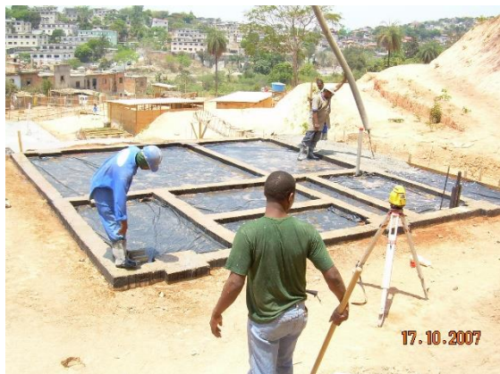
Figura 15: Baldrame finalizados. Fonte: Rafael Netto, outubro 2007
