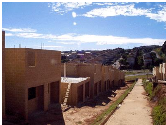
Figura 8: Residencial ASCA durante a edificação do segundo pavimento.
