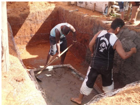
Figura 28: TEVAP: revestimento com cimento após telamento.
