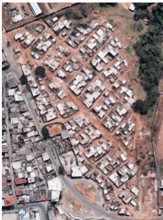
Figura 45: Vista de topo da Vila Eliana Silva, no início de 2019. As quadras têm tamanhos distintos e são divididas em lotes individuais.
