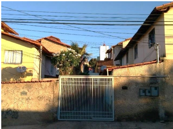
Figura 47: Vial transversal de acesso restrito, delimitada por portão.
