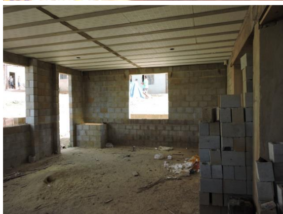
Figura 39: Obras da construção do anexo, corresponde ao refeitório. Fonte: Autoria desconhecida, maio 2016. Disponível em: dialogoseliasilva.wordpress.com
