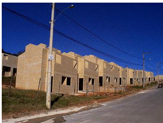
Figura 9: Casas do Residencial ASCA com esquadrias e telhado ainda ausentes.
