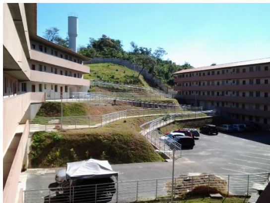
Figura 64: Vista geral do conjunto Residencial Serra Verde. Fonte: acervo ASCA-BH, junho 2015
