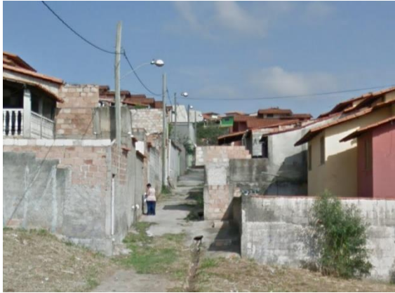
Figura 49: Viela longitudinal aberta. Fonte: Google Street View, 2019
