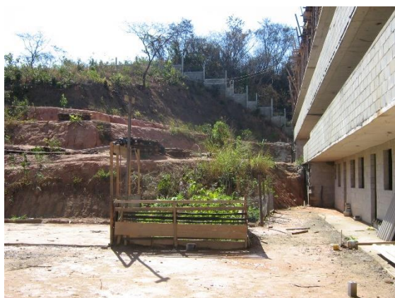
Figura 19: Horta cultivada no canteiro de obras para o preparo dos alimentos.
