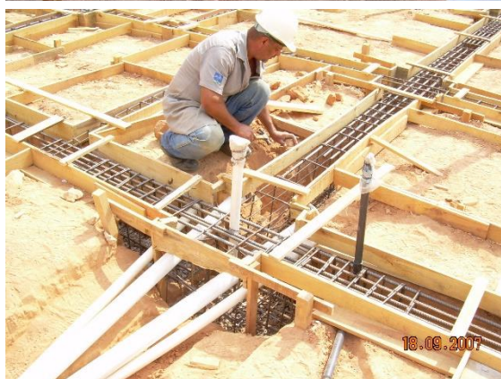
Figura 14: Ferragens e fôrmas instaladas para receberem o concreto.
