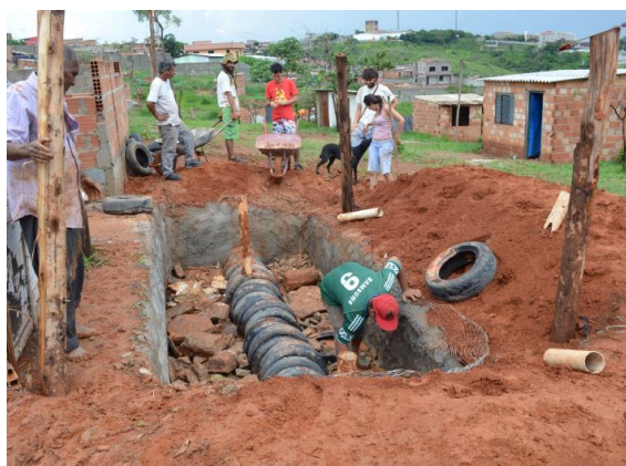
Figura 29: TEVAP: preenchimento com entulho e pneus.
