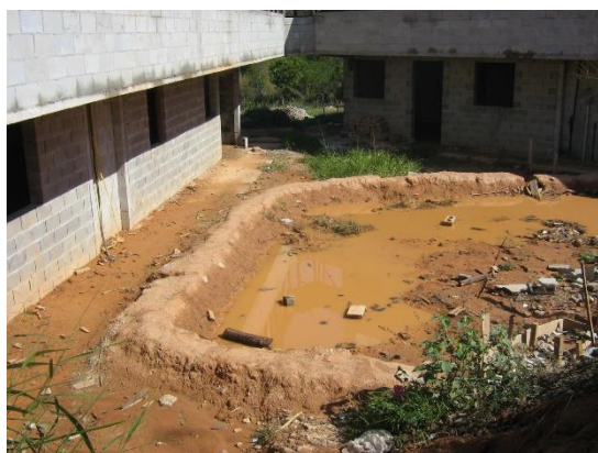
Figura 20: Contenção improvisada para se evitar empoçamentos junto aos blocos, exemplo da criatividade técnica.
