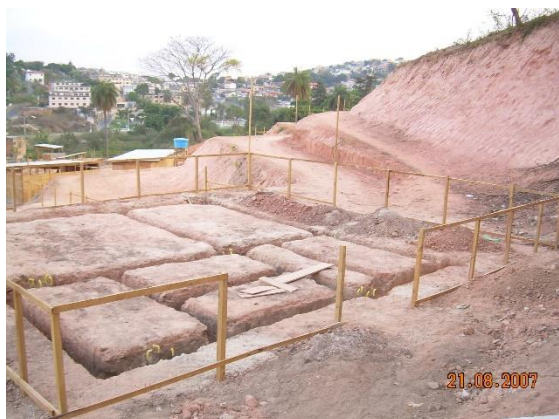
Figura 13: Valas abertas para receber as fôrmas.
