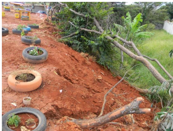
Figura 35: Terreno instável após cortes indevidos.
