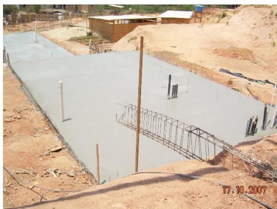
Figura 16: Laje de piso finalizada. Fonte: Rafael Netto, outubro 2007
