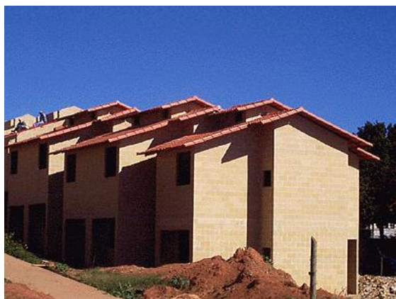
Figura 10: Residencial ASCA em etapa já bastante avançada, com telhado finalizado.
