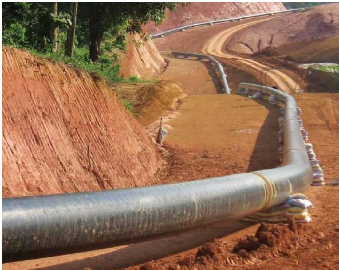
FIGURA 2. 1 – Exemplo de um mineroduto em construção
