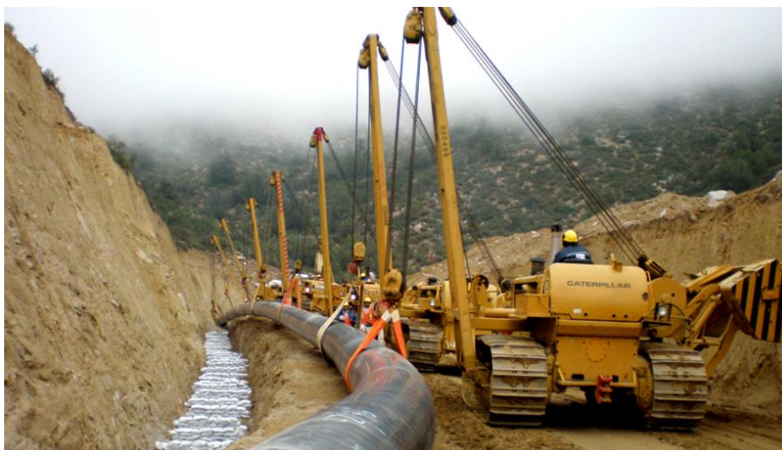
FIGURA 2. 4 – Abaixamento de um mineroduto em construção
