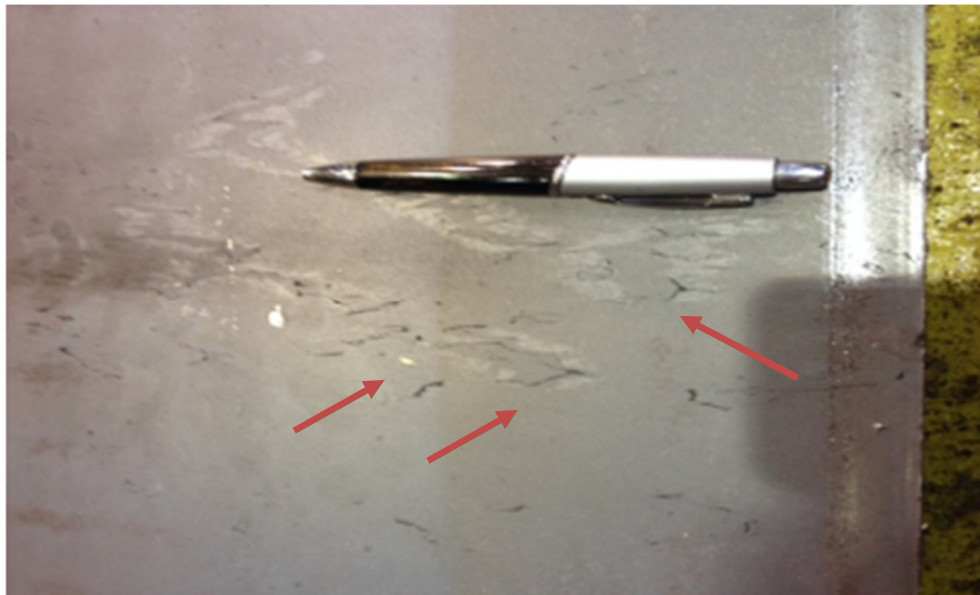
Figura 3.9 – Defeito trinca estrela em chapa grossa.
