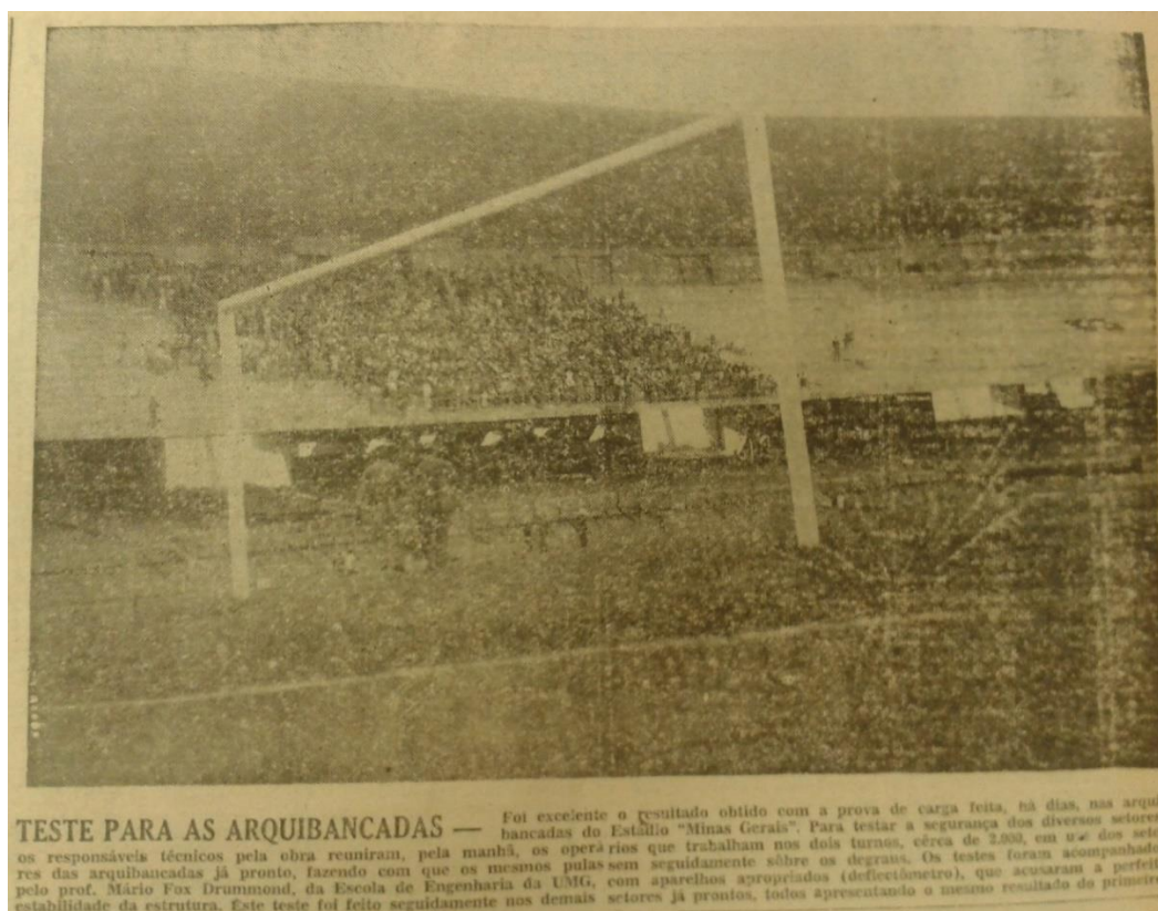
FIGURA 14 – Foto do teste para as arquibancadas do Mineirão, 1965. Fonte: O Estado de Minas
