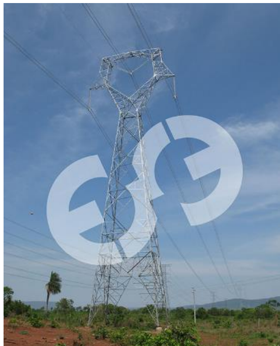
Figura 3.9 – Torre Autoportante “Cara de Gato”. [8]
