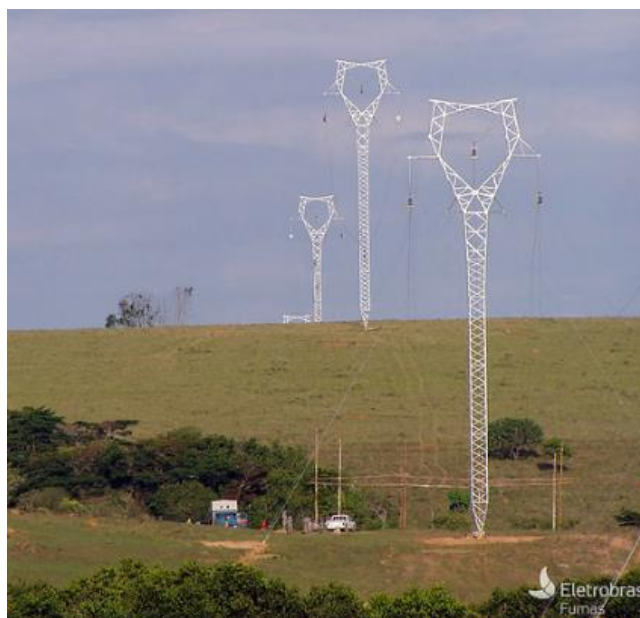
Figura 3.4 – Torres Estaiadas “Cara de Gato” próximas da Subestação de Foz do Iguaçu [27]
