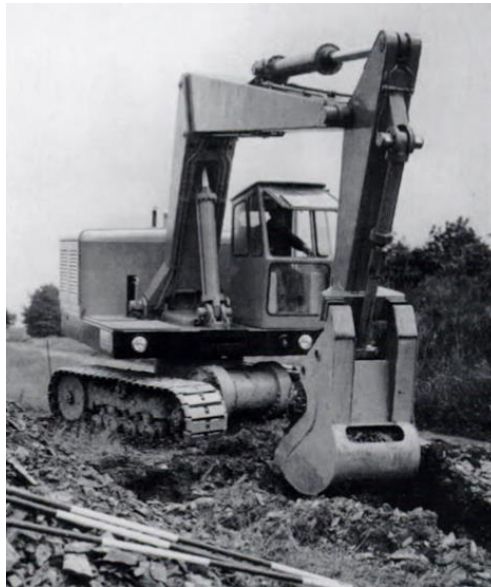
Figura 2. Primeira escavadeira totalmente hidráulica fabricada no mundo. Modelo Demag B504. Fonte: HADDOCK, 2007.
