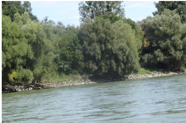
Figura 4-16: Rio Danúbio – Áustria - Vista de margens em enrocamento
