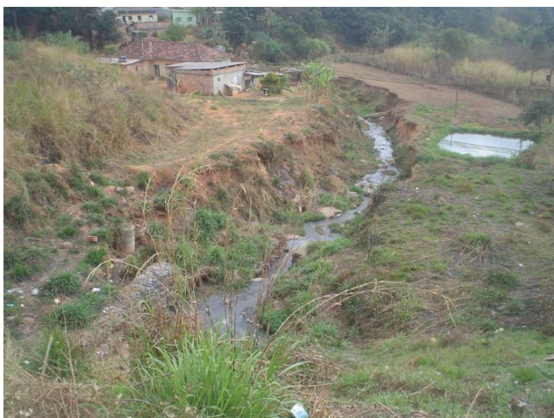
Figura 8-37: Trecho 18 à jusante após o bueiro da rua Ópera (Fonte: Evangelista, 2011)
