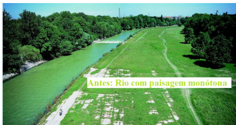
Figura 4-25: Trecho do rio Isar retificado com estabilização de margens Fonte: Mahida (2013)
