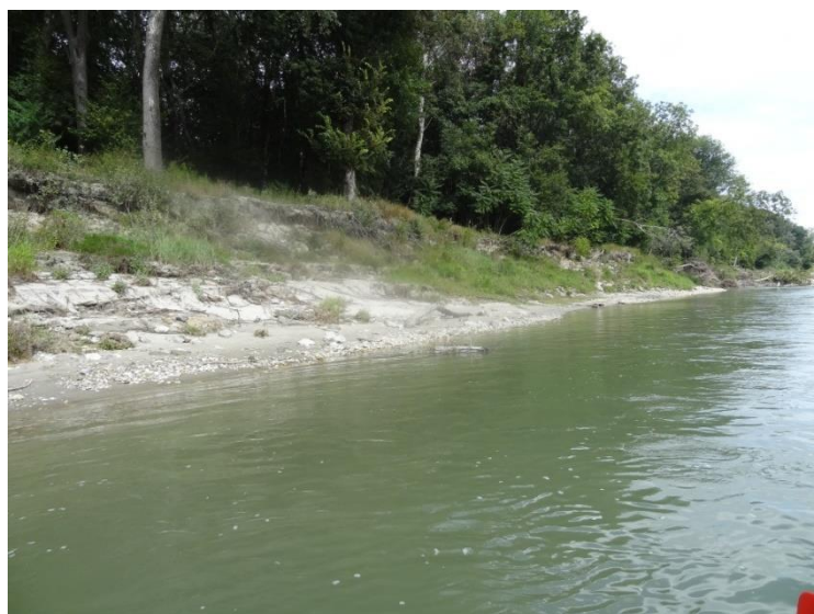
Figura 4-17: Rio Danúbio – Áustria - Vista de margens onde o enrocamento foi removido
