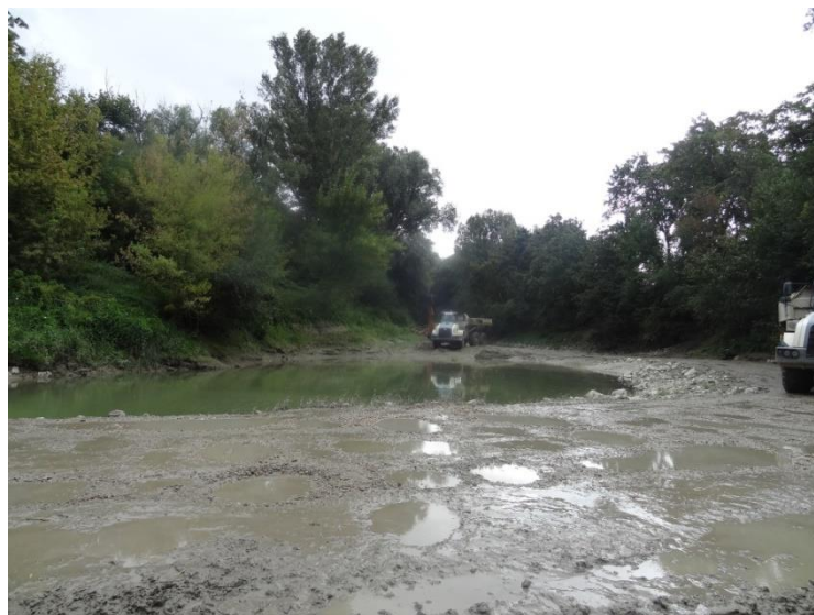
Figura 4-19: Rio Danúbio – Áustria – Meandro abandonado sendo religado ao rio
