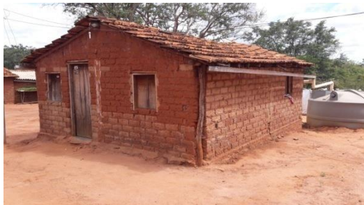
Figura 60: Foto de casa de adobe. Acampamento São Francisco. Lapinha. Fonte: acervo da autora, 2018.
