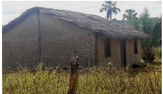
Figura 54: Foto de casa de adobe com cobertura de palha. Barro Vermelho. Fonte: acervo da autora, 2018.
