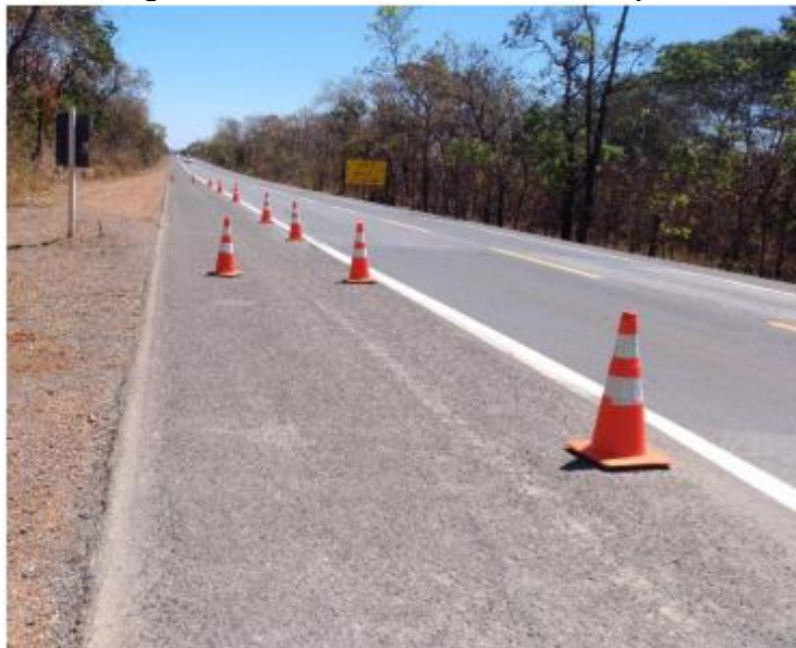
Figura 3.8: Posicionamento de cones na pista
