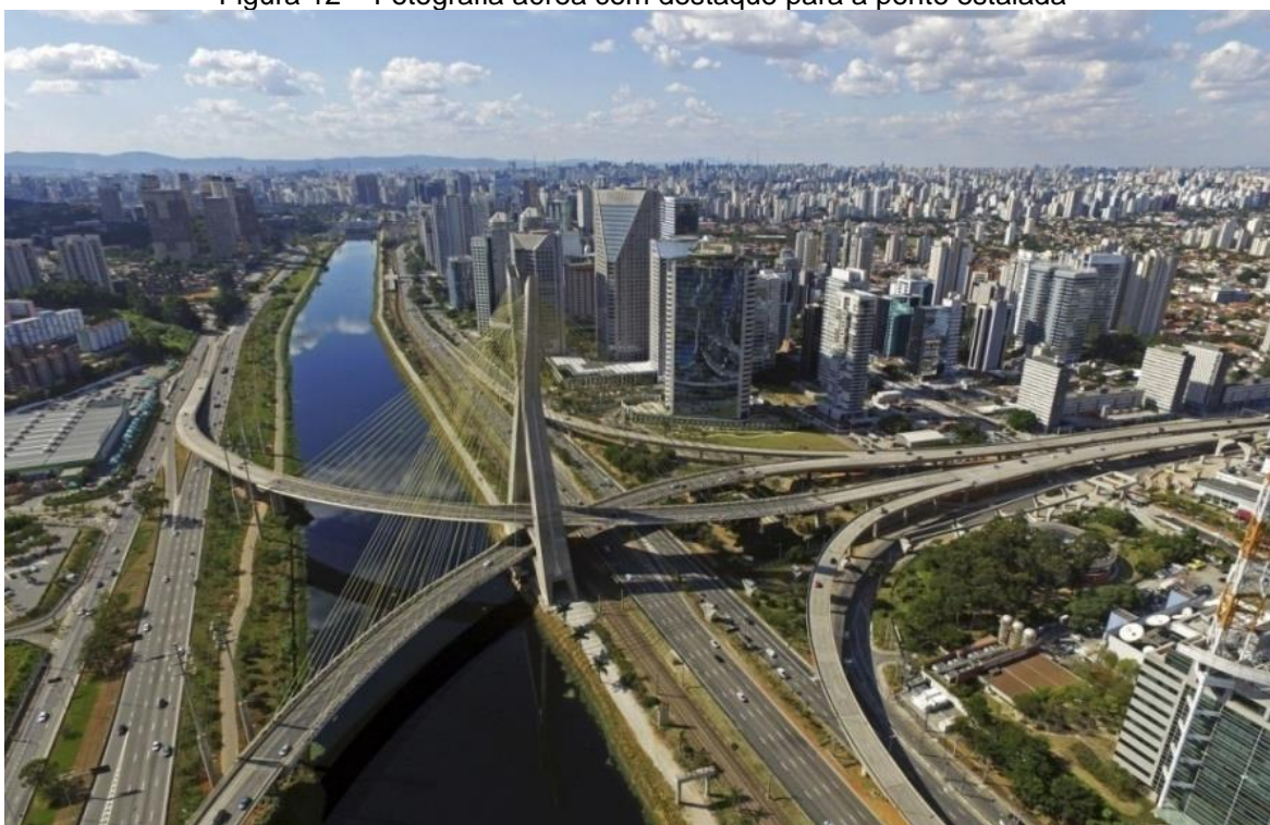
Figura 12 – Fotografia aérea com destaque para a ponte estaiada
