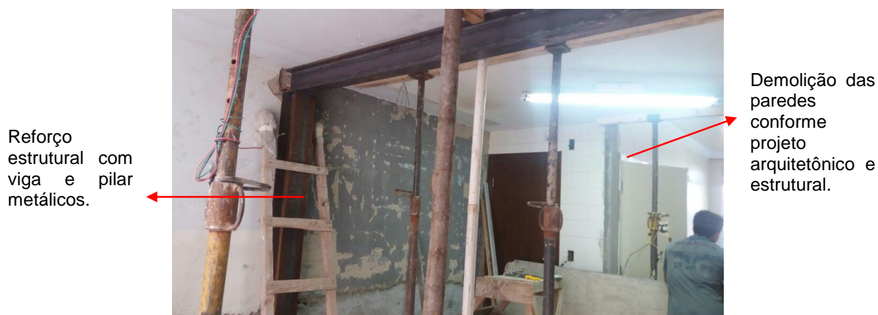
Figura 16 – Reforço estrutural Fonte: Acervo da autora
