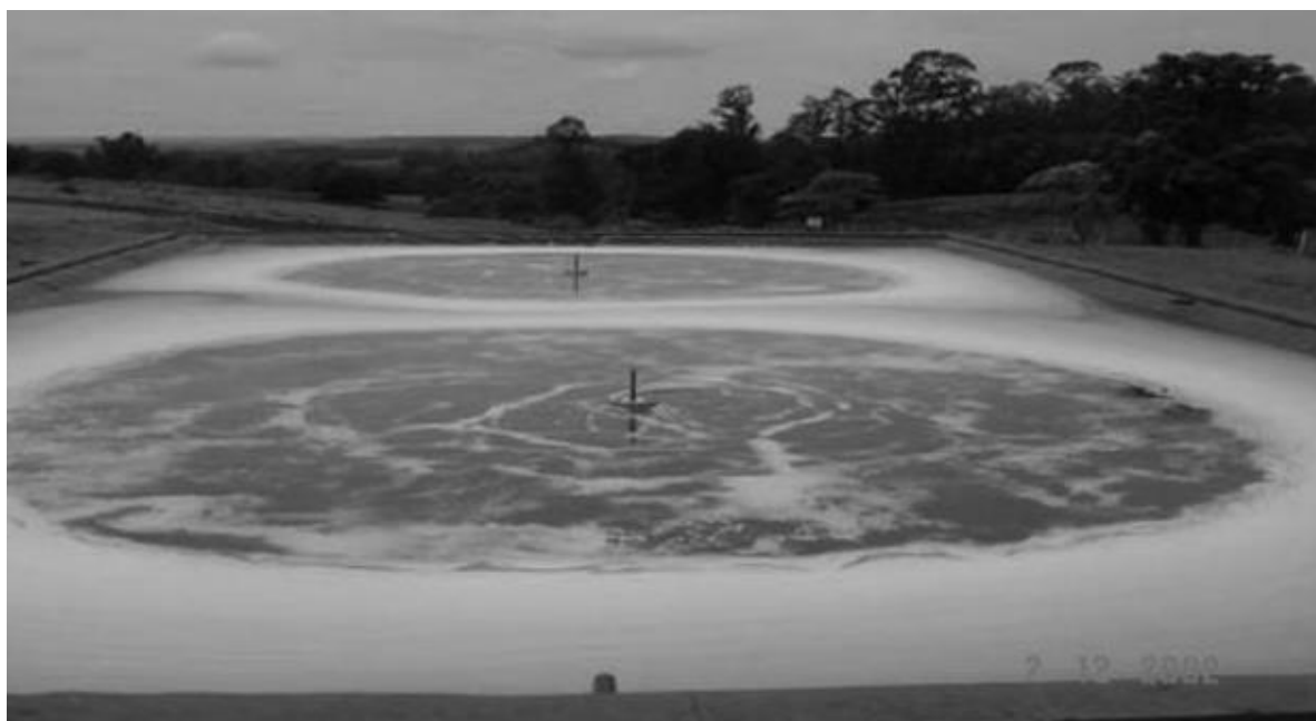
Figura 12 – Lagoas aeradas aeróbias de mistura completa do aterro controlado de Londrina – PR.
