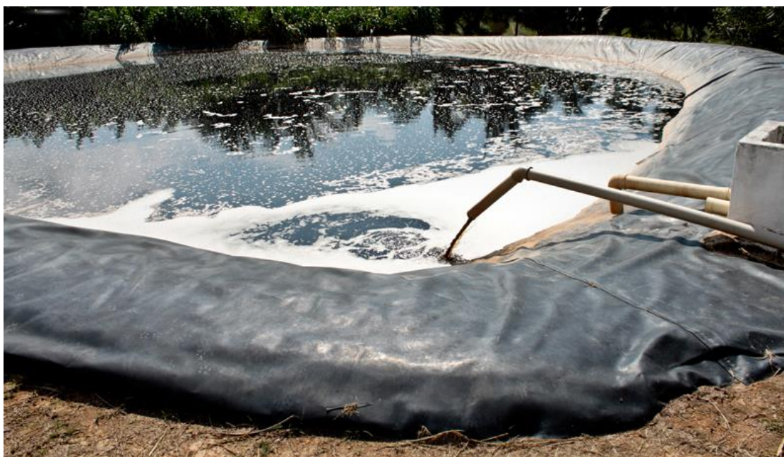
Figura 10 – Lagoa anaeróbia utilizada para o tratamento do lixiviado de aterro sanitário do município de Brusque-SC.
