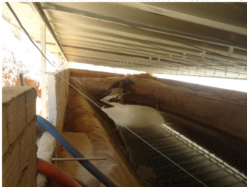
Figura 6 – Visão geral de um tanque de armazenamento do lixiviado do aterro sanitário de Macaúbas em Sabará – MG.
