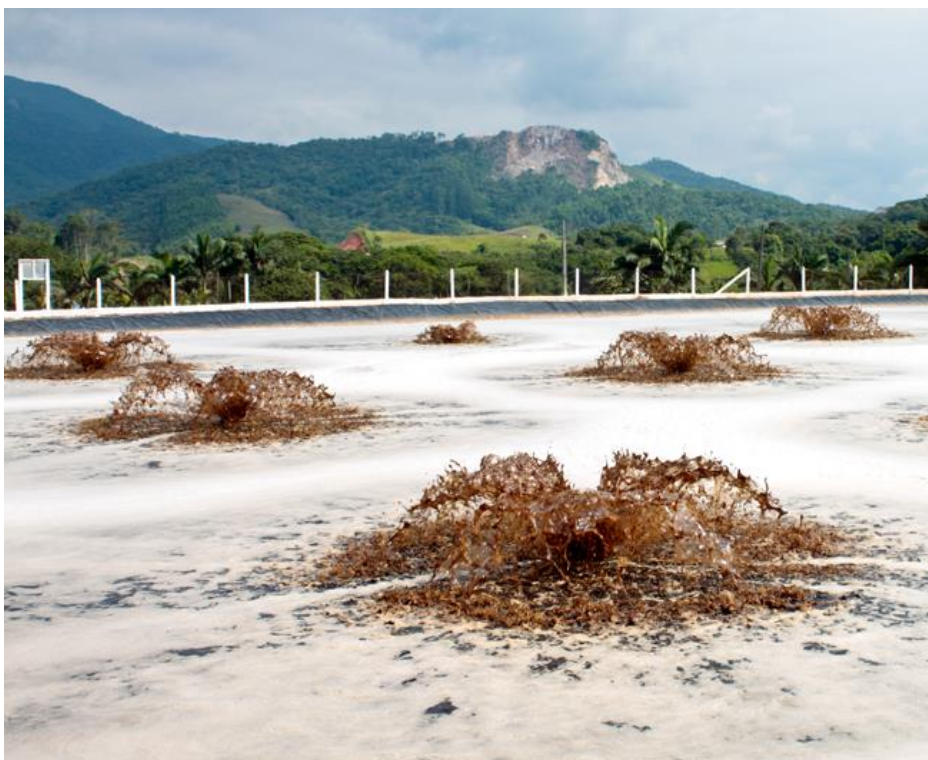
Figura 11 – Lagoa aerada utilizada para o tratamento do lixiviado de aterro sanitário do município de Brusque-SC.
