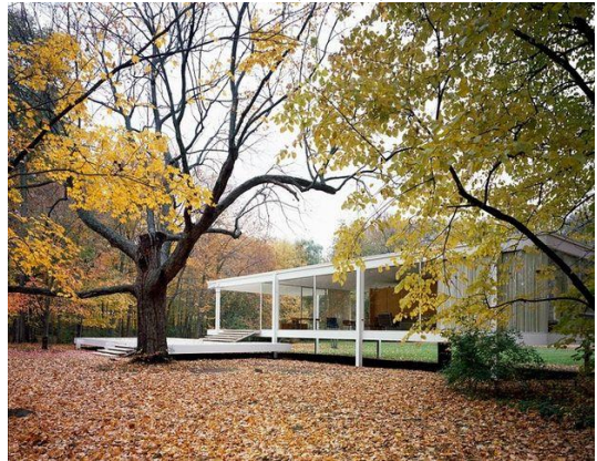
Figura 23: Residência Farnsworth, Mies van der Rohe, 1951, Illinois, EUA
