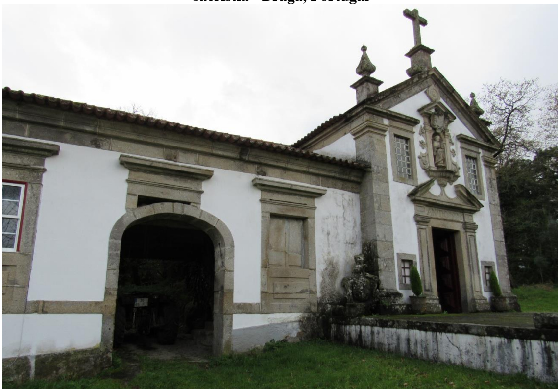
Figura 122: Quinta das Lages - Passagem de carros para onde se abre a porta da sacristia - Braga, Portugal
