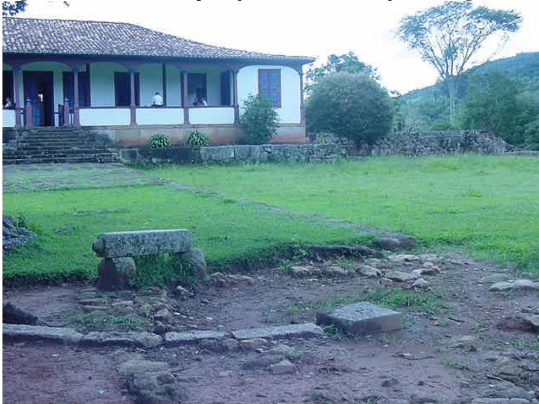
Figura 130: Fazenda Boa Esperança – detalhe das fundações do antigo chafariz
