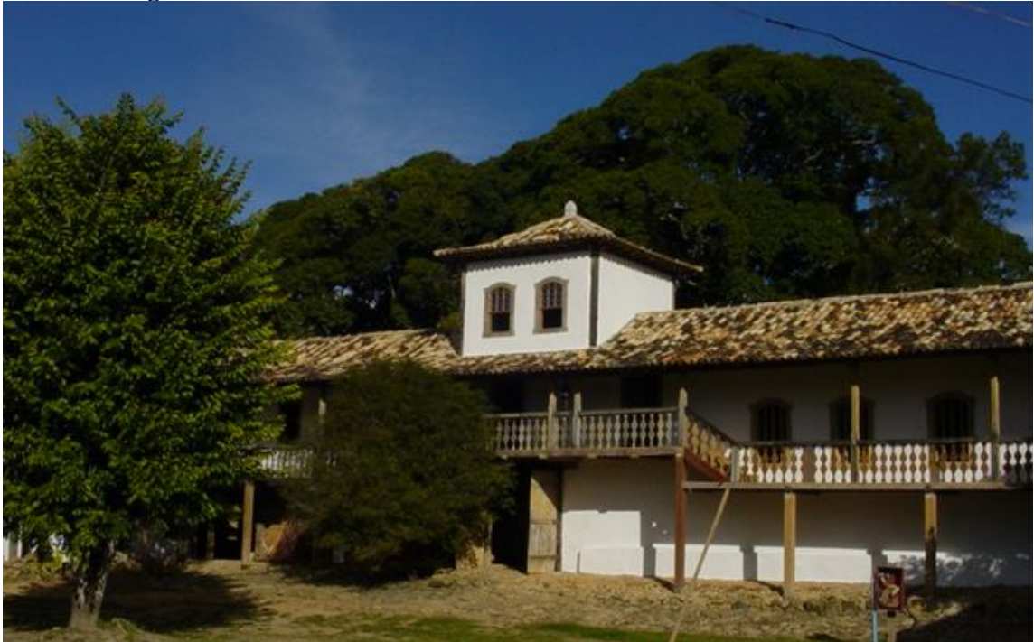
Figura 67: Vista dos fundos da sede da Fazenda do Rio São João
