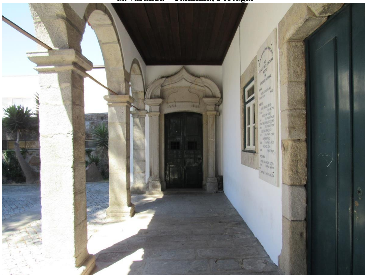
Figura 132: Antiga Casa do Corpo da Guarda de Caminha, com capela na extremidade da varanda - Caminha, Portugal
