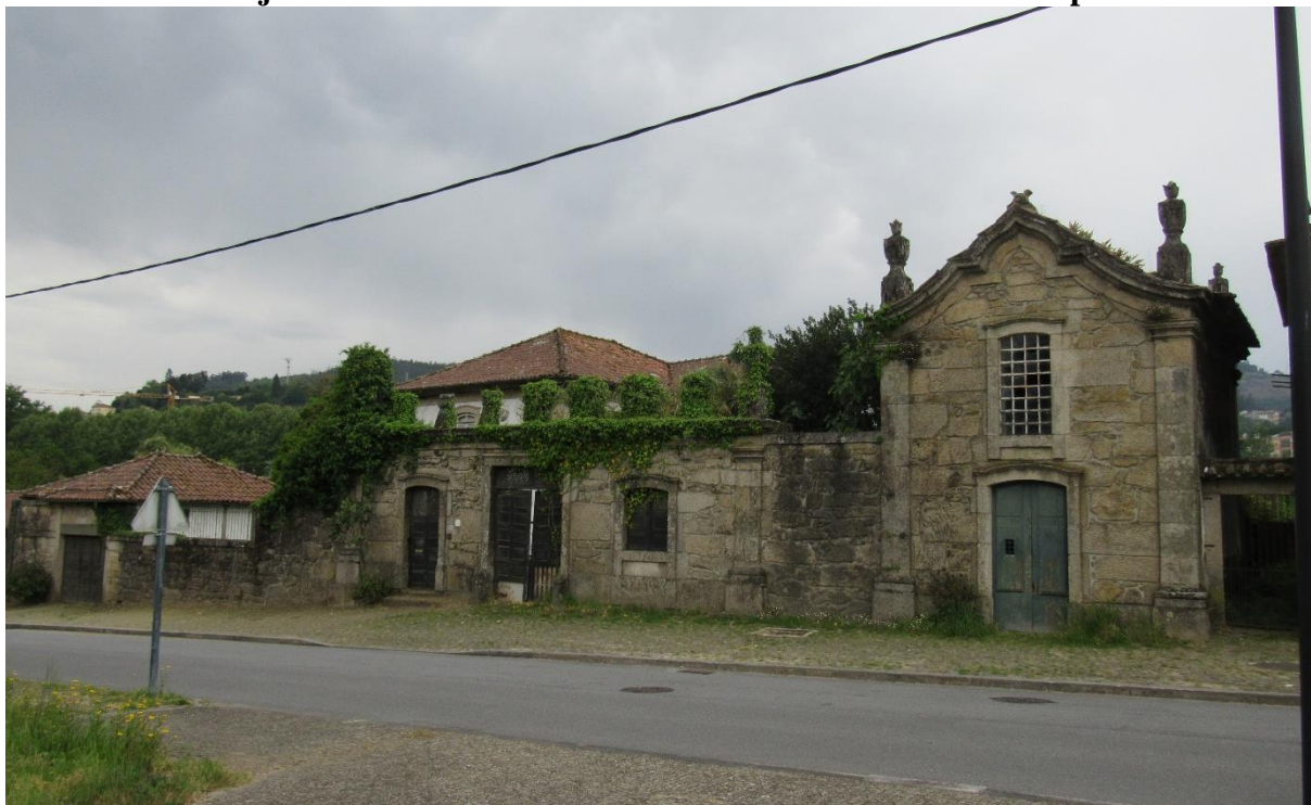
Figura 36: Residência urbana em Arcos de Valdevez, onde a capela conforma um pátio em conjunto com o setor residencial e o muro de alvenaria de pedras
