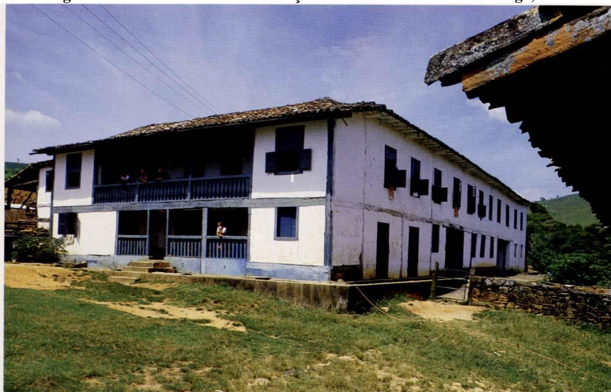
Figura 29: Sede da Fazenda Conceição das Corvinas em Barra Longa, MG
