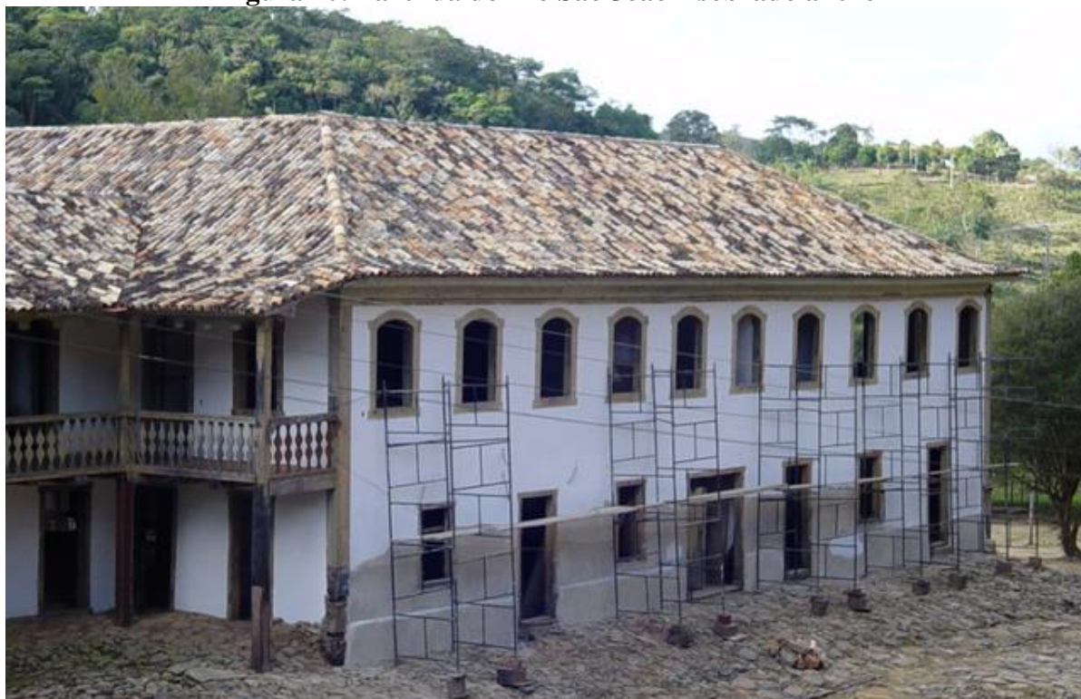
Figura 70: Fazenda do Rio São João – sobrado anexo
