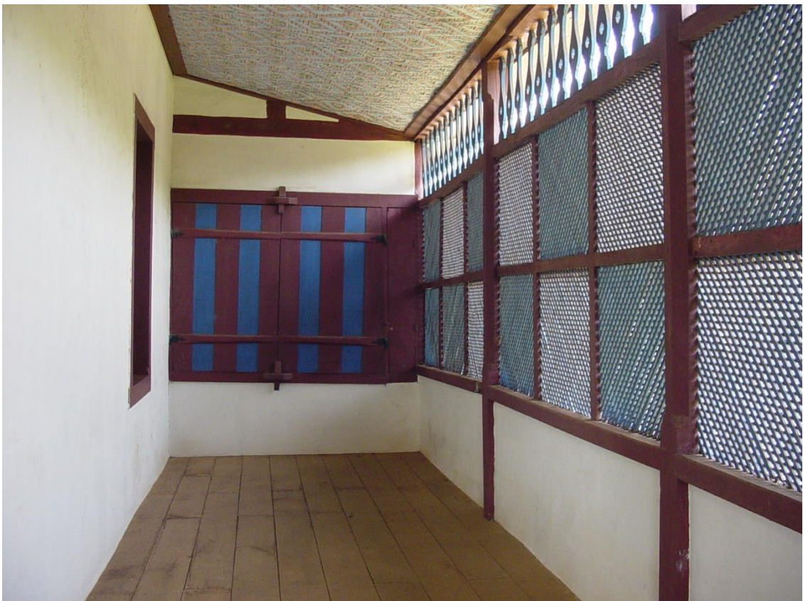
Figura 104: Vista interna da varanda treliçada com a janela ao fundo que se comunica com a ermida
