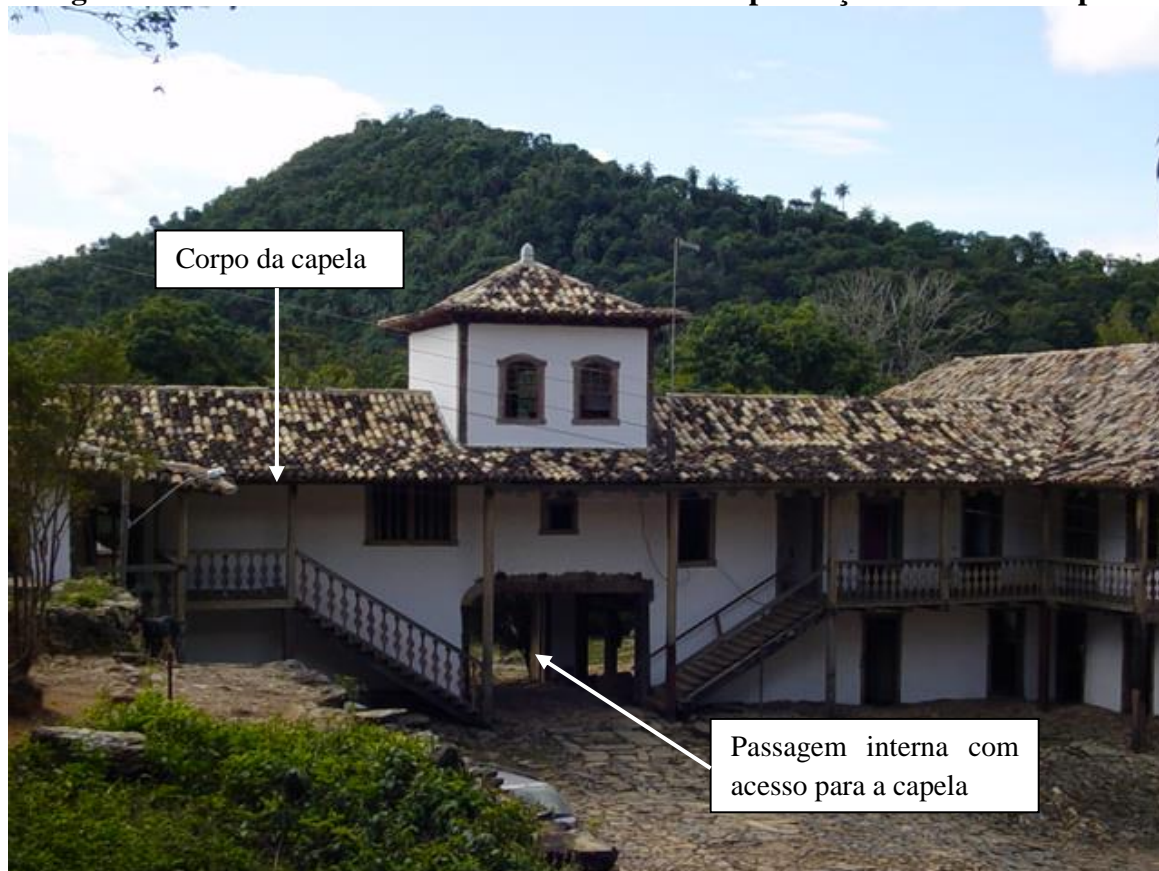
Figura 69: Fazenda do Rio São João - detalhe da implantação e acesso da capela
