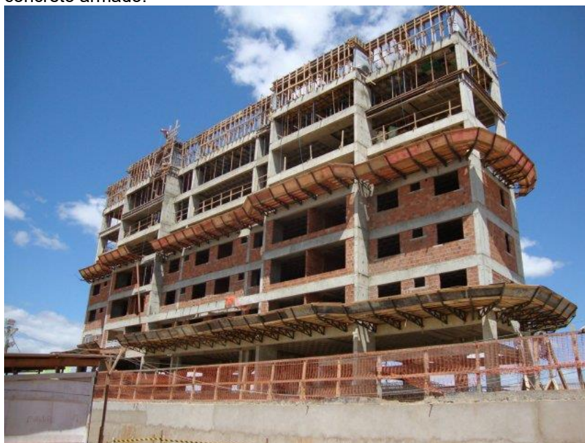
Figura 43 – Construção de edifício com pilares e vigas retilíneas em concreto armado.
