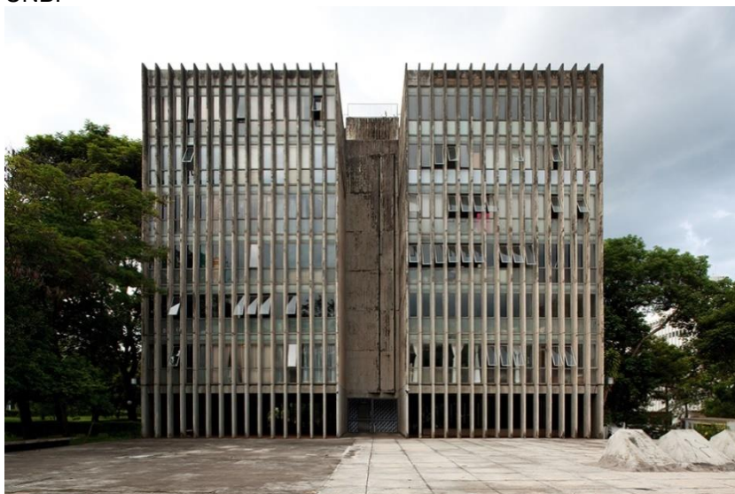
Figura 65 – Edifício projetado por Mayumi Watanabe de Souza Lima e Sérgio de Souza Lima para funcionários da Universidade de Brasília – UNB.
