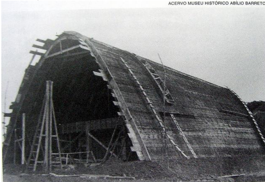
Figura 44 – Fôrmas para construção da Igreja da Pampulha, em Belo Horizonte, em 1943.
