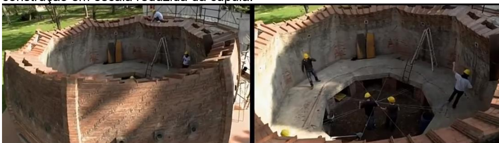
Figura 35 – Cena do documentário “Great Cathedral Mystery”, com detalhe à construção em escala reduzida da cúpula.
