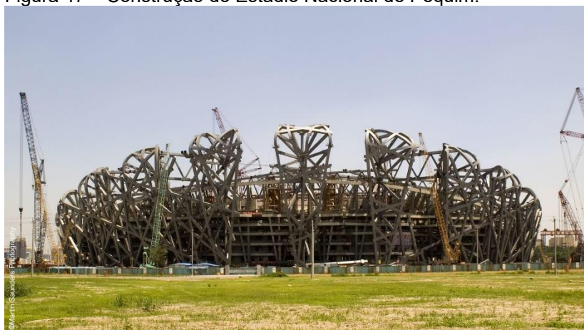
Figura 47 – Construção do Estádio Nacional de Pequim.
