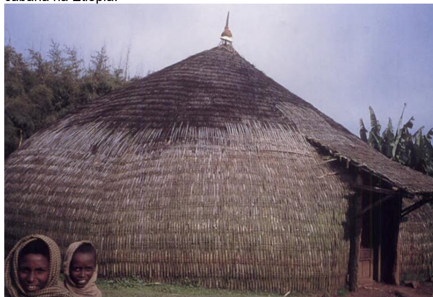
Figura 52 – Bambu utilizado como estrutura e tecido de cobertura em cabana na Etiópia.
