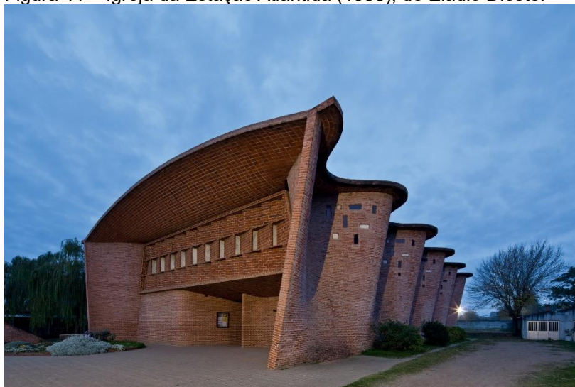
Figura 41 – Igreja da Estação Atlantida (1958), de Eladio Dieste.
