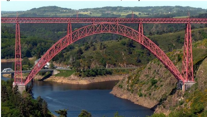
Figura 40 – Viaduto de Garabit em Cantal, França.
