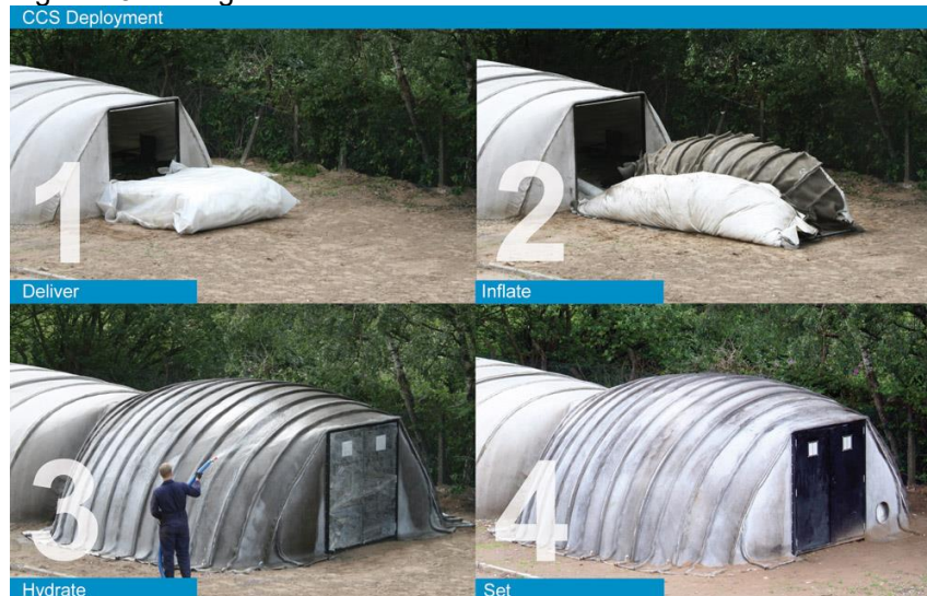
Figura 45 – Abrigo construído com tecidos misturado com concreto.
