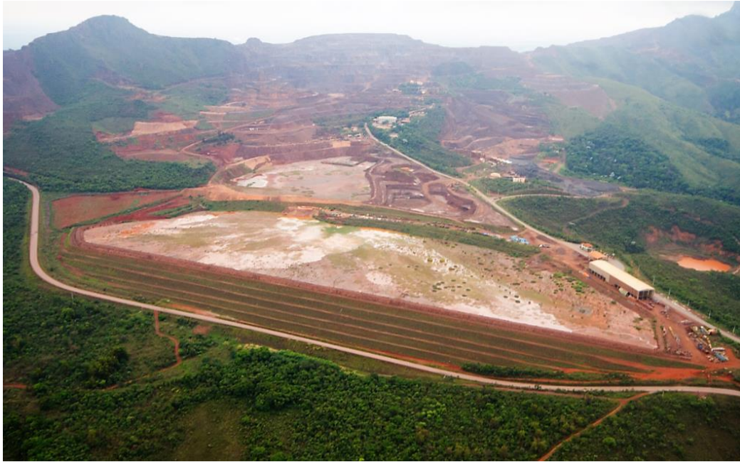
Figura 28. Barragem 3 em Itatiaiuçu 4ª prioridade
