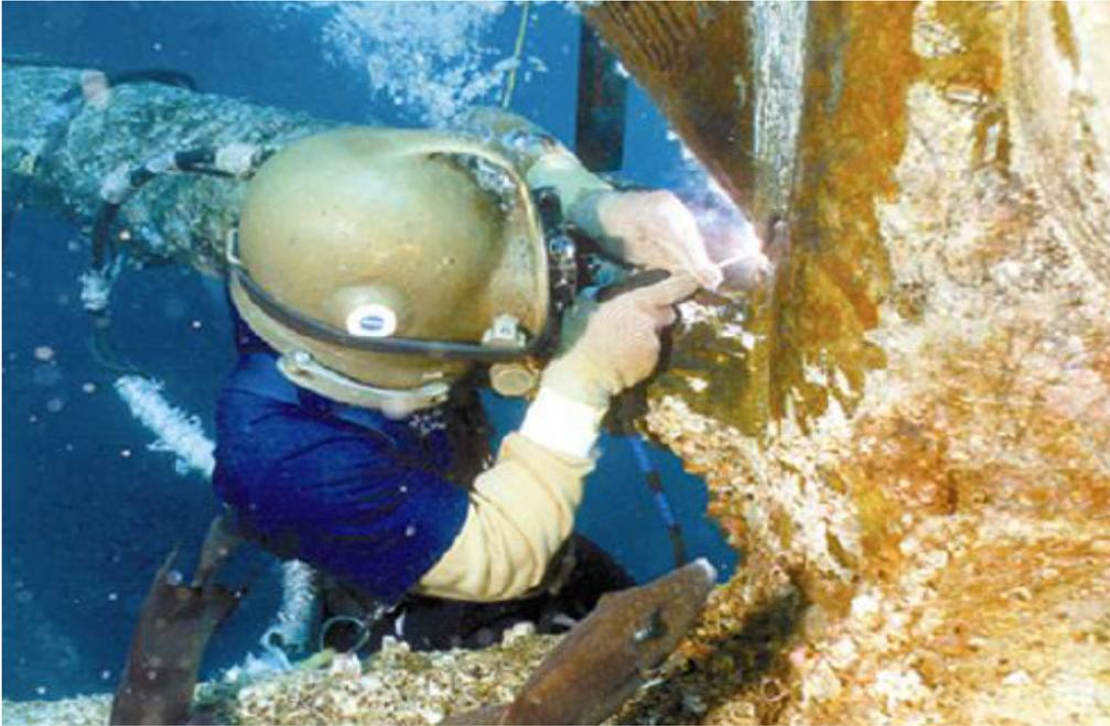
Figura 3.2: Procedimento de Soldagem Subaquática Molhada para Reparo
