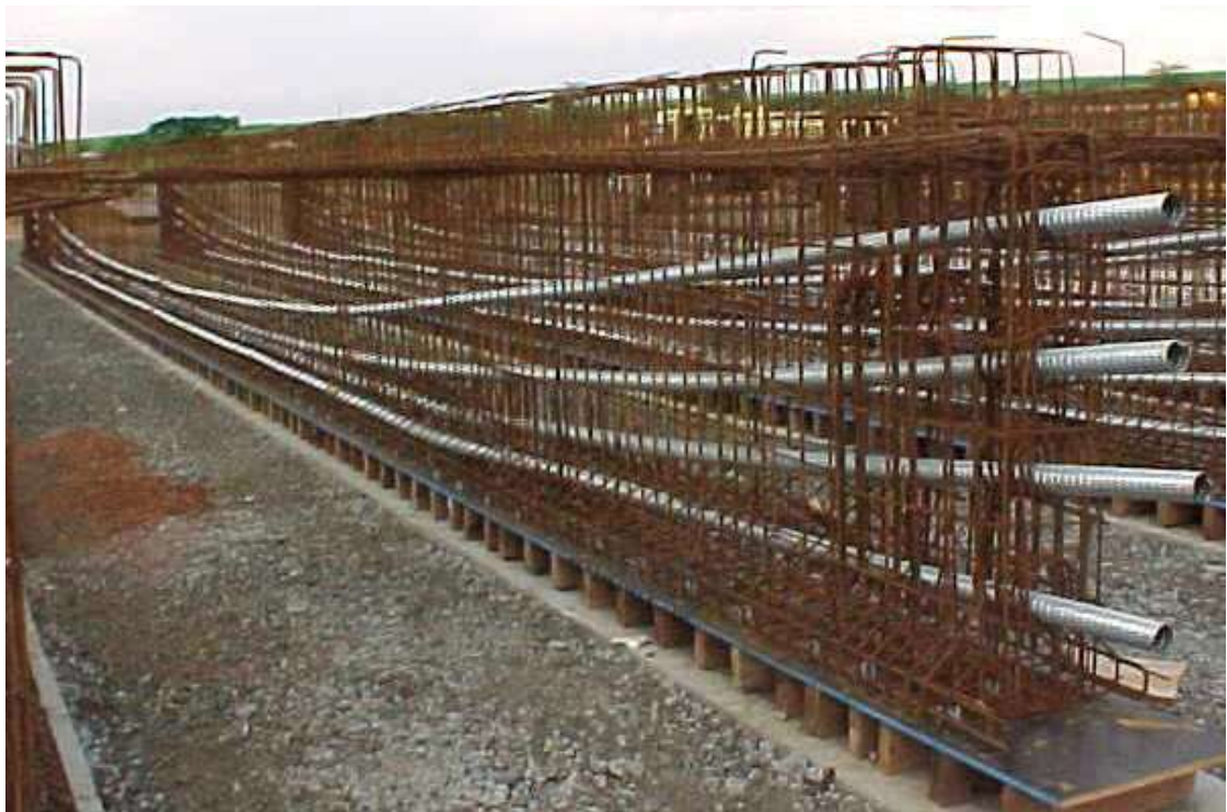
Figura 3 – Montagem das armaduras e fixação das bainhas (RODRIGUES,2008)
