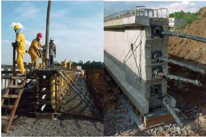
Figura 4 – Montagem das formas e concretagem
