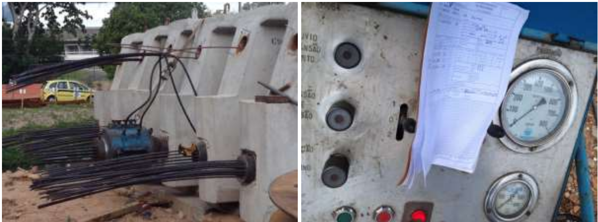
Figura 5 – Macaco hidráulico executando a protensão e controle de tensões
