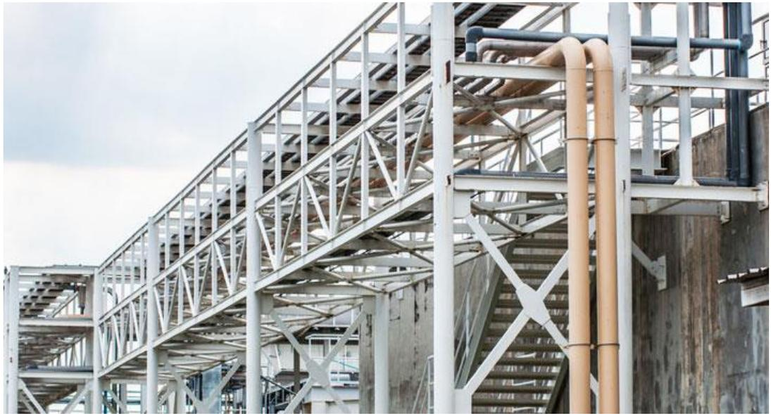
**Figura 1:** Pipe Rack composto por uma estrutura metálica (Fonte: [www.setxind.com](http://www.setxind.com)).
