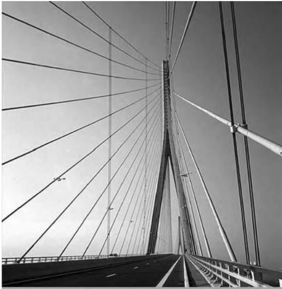
Figura 3-18 - Cross-ties na ponte Normandy (CAETANO, 2007).
