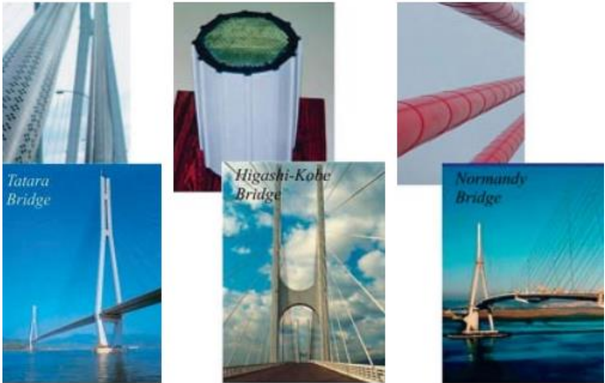
Figura 5-3- Modificações aerodinâmicas efetuadas em diferentes pontes do mundo. (SVENSSON, 2012)
