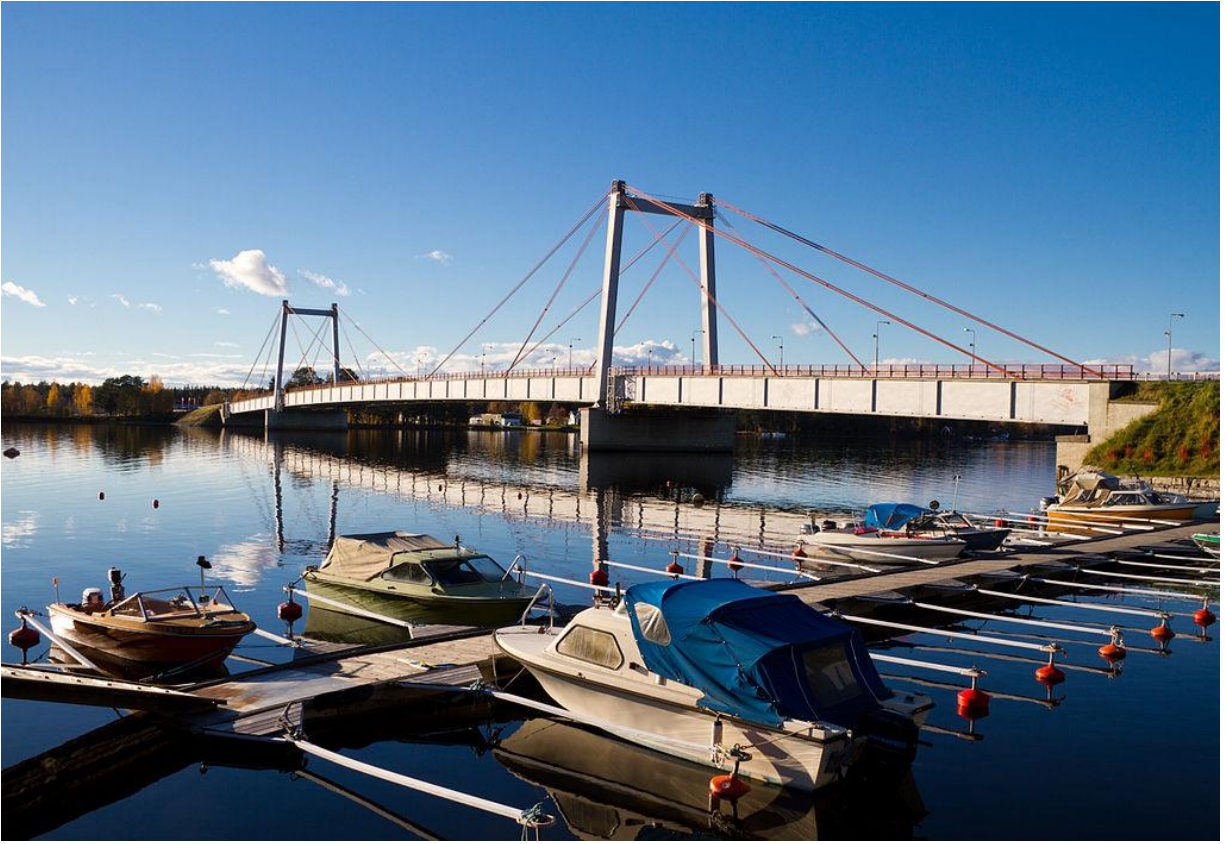
Figura 1-2 Ponte Strömsund (Strömsund... ,2016)
