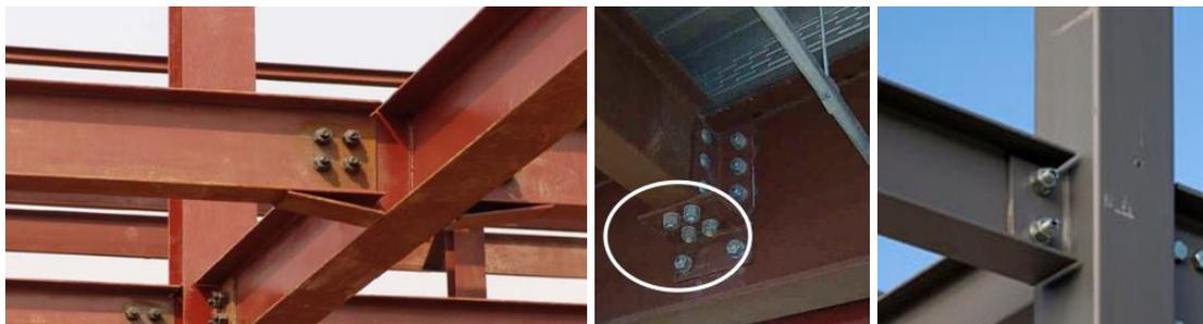
**FIGURA 2:** Detalhes de ligação (Rígida, Semirrígida, Flexível)
