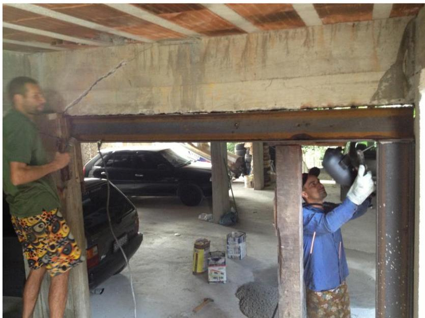
Fig. 13 – Viga Metálica de Esforço Cortante
