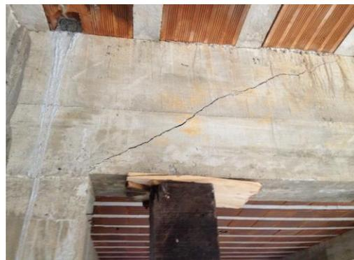
Fig. 11 – Fissura Cortante na Viga
