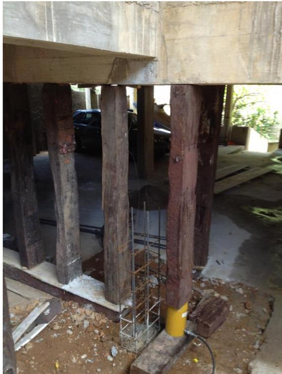
Fig.14 – Pilar Recolocado com recuo de 70 cm
