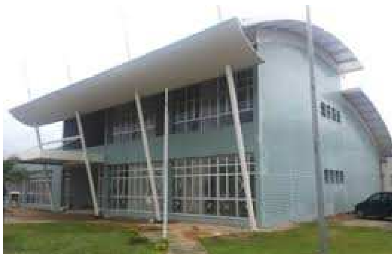
Figura 7: Fachada Bloco E (unidade administrativa).Fonte: Ribeiro Alvim Engenharia
