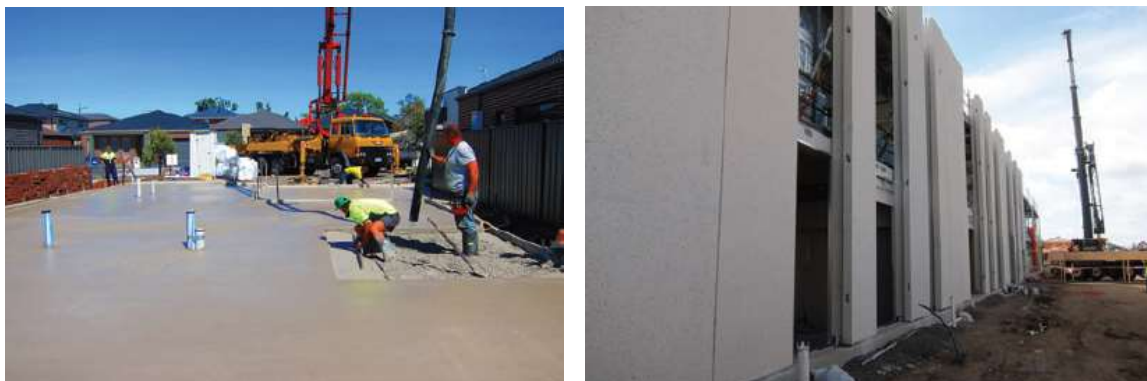
Figura 3.5 - piso residencial e painéis externos pré-fabricados pela empresa E-Crete na Austrália
