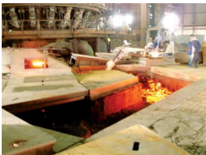
Figura 5: Estrutura de concreto exposta às altas temperaturas. Unidade produtiva do Alto Forno.
