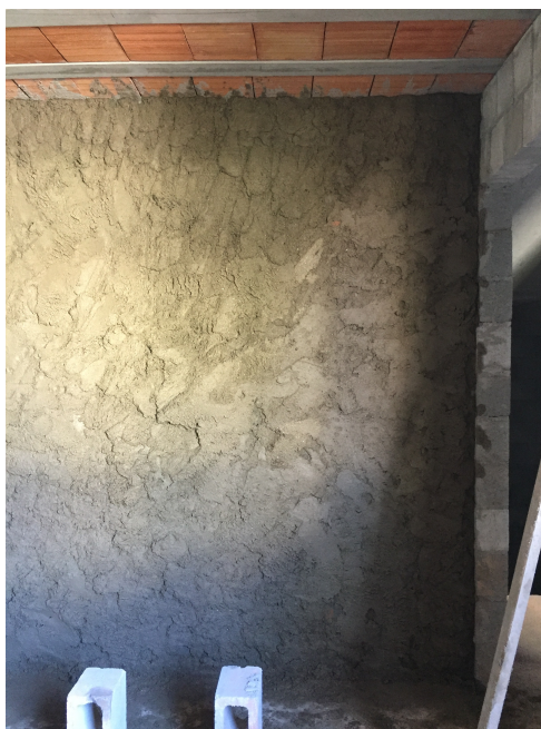
Figura 45 - Reboco isolante – Finalizado Fonte: Acervo pessoal
