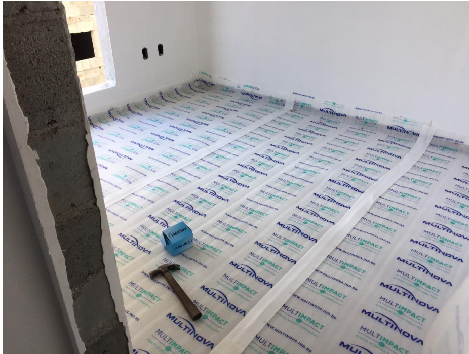
Figura 47 - Instalação da manta acústica Fonte: Acervo pessoal
