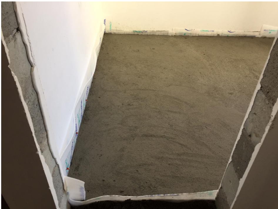
Figura 48 - Contrapiso sobre a manta acústica Fonte: Acervo pessoal
