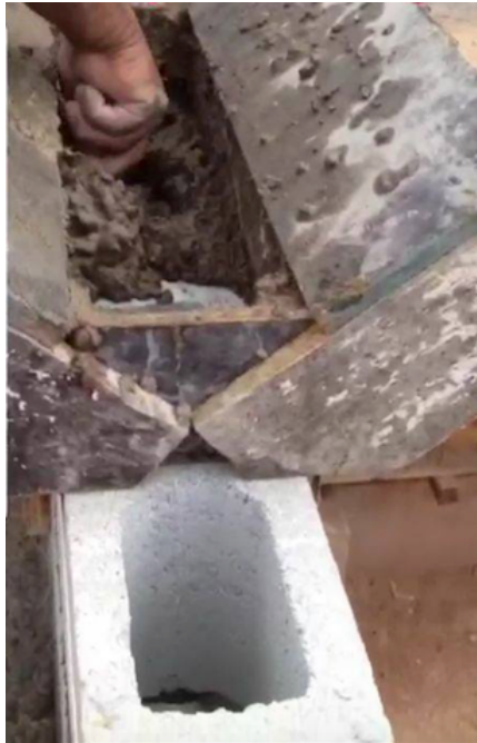
Figura 46 - Bloco de concreto sendo preenchido com a vermiculita Fonte: Acervo pessoal
