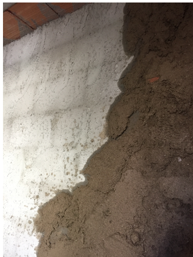
Figura 44 - Reboco isolante - Em processo Fonte: Acervo pessoal
